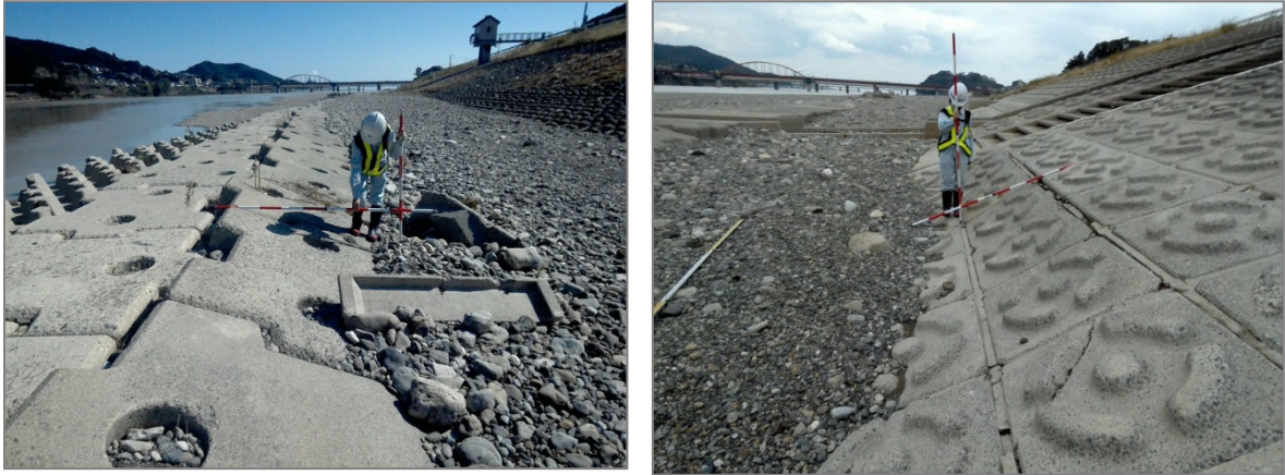
図 5.4.2 出水期後点検状況 (2017 年台風 21 号)
