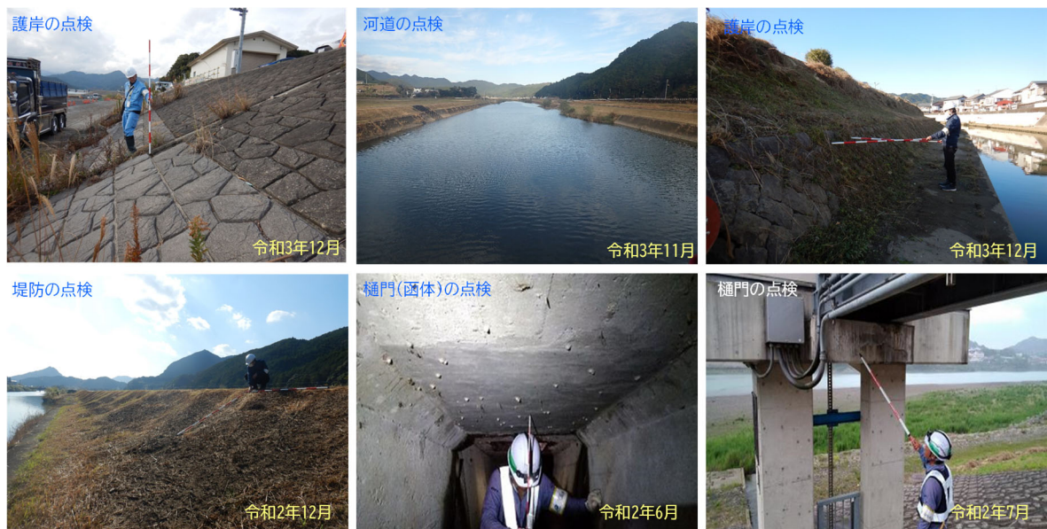
図 5.4.1 出水期前・台風前の点検状況
