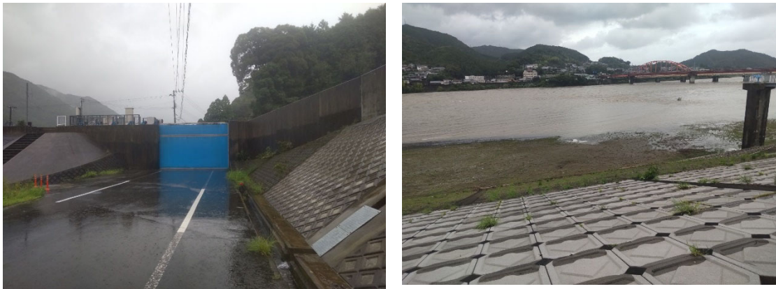
図 5.3.2 出水時の河川巡視状況（施設の操作状況、河川の状況確認）
