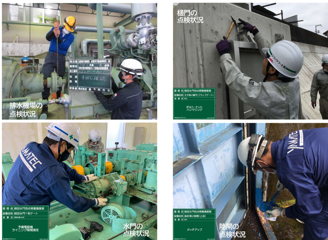
図 5.4.4 機械設備・電気通信施設の点検状況
