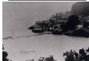
熊野川の氾濫状況(紀宝町 1.8km付近)
