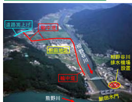
相野谷川 輪中堤 (鮎田地区)
