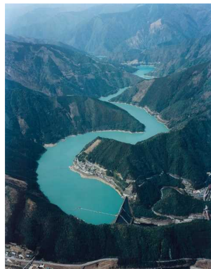
図-2.23 風屋ダム付近（奈良県十津川村）
