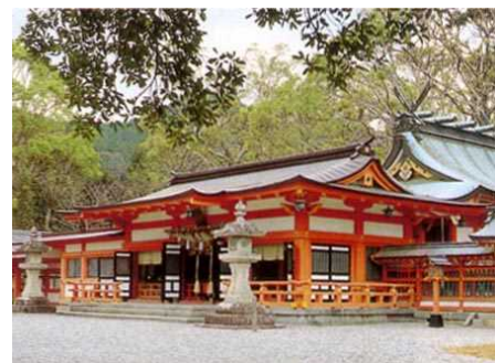
図-1.20 熊野速玉大社【国指定史跡】 （熊野川下流部）
