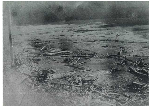
大字川津付近、洪水による家屋喪失
