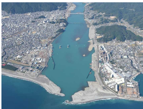
図-2.32 熊野川河口部 (和歌山県新宮市, 三重県紀宝町)
