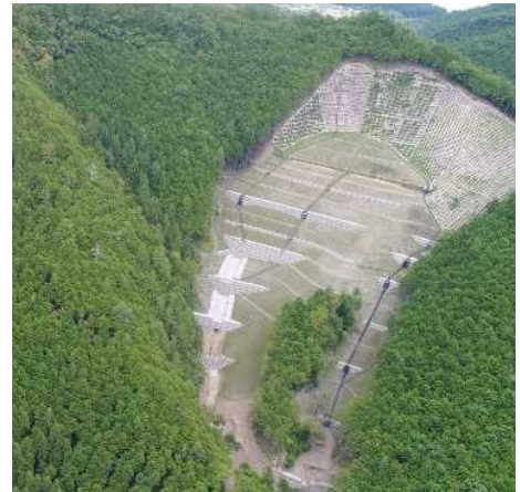
写真2 治山事業による土砂流出抑制
