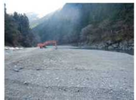
写真3 ダムの堆積土砂掘削状況
