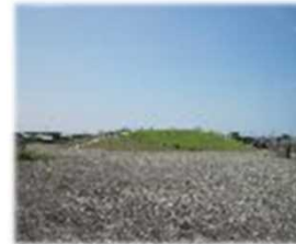
地域防災対策 (津波避難地整備など)
