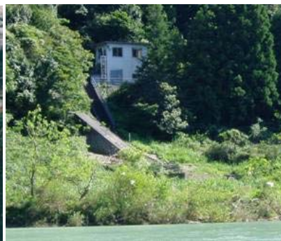
直轄上流端の揚水堰
