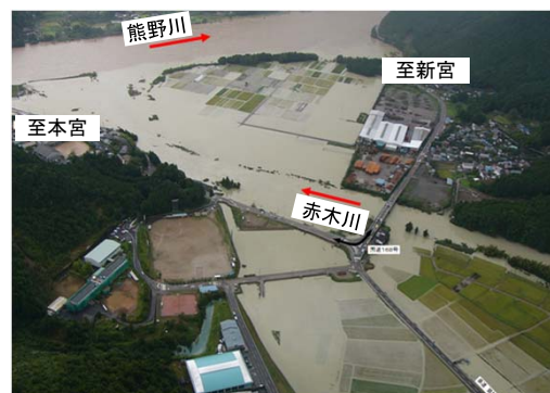
▲H16.8月出水での日足地区の被害状況
