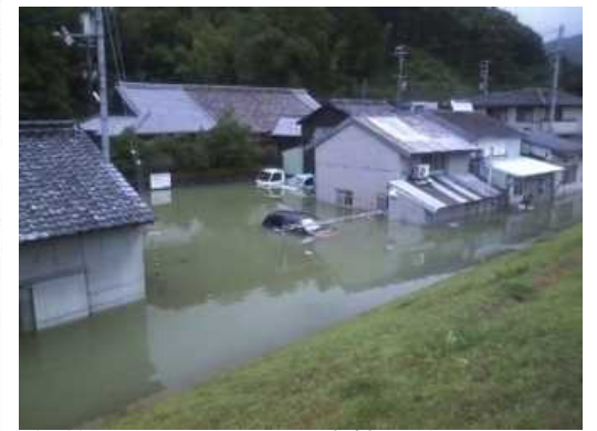
相筋地区における堤防越水等による浸水
