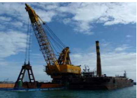
グラブ浚渫船による掘削状況 (平成26年11月撮影)
