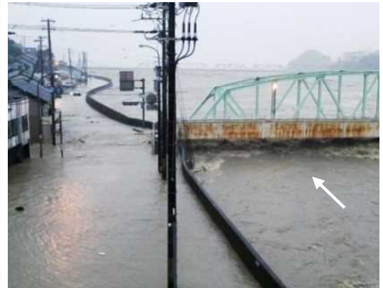
成川地区における堤防越水による浸水（熊野川左岸2.3k）
