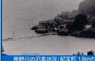
熊野川の氾濫状況(紀宝町 1.8km付近)
