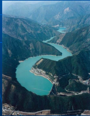
風屋ダム付近（奈良県十津川村）
