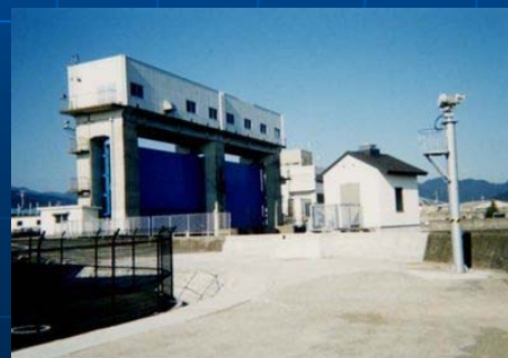
水門等の点検実施
