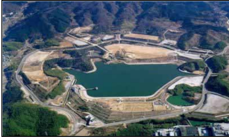
白川ダム(奈良県天理市) 白川溜池の堤体を4.5m 嵩上げし、改築した治水ダム
