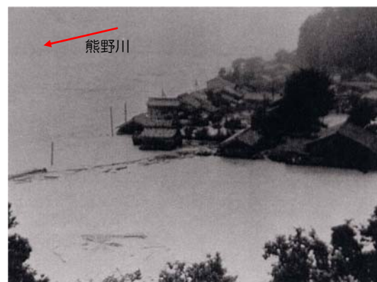
写真 14 熊野川(矢淵地区)の浸水状況(伊勢湾台風)
