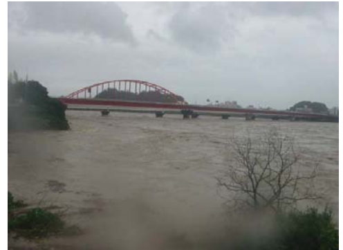
写真8 洪水時の熊野川(熊野大橋H16.8)
