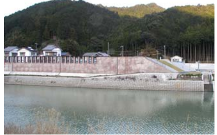
写真 12 輪中堤 (相野谷川左岸)
