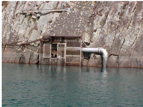
写真 45 取水口跡（新宮市）
