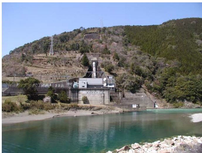
写真 21 十津川第二発電所
