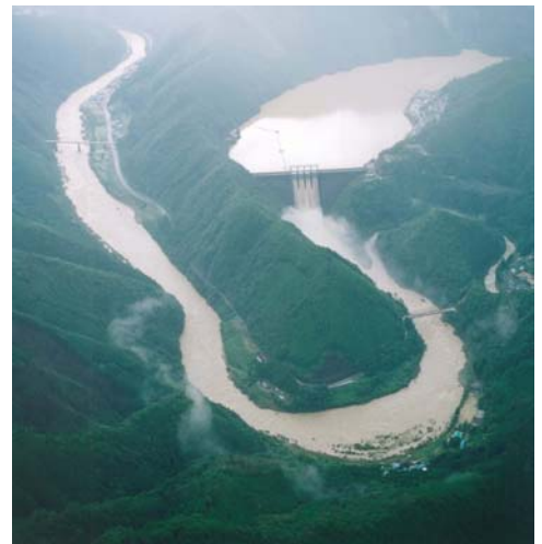
写真9 洪水時の風屋ダム(H15.8)
