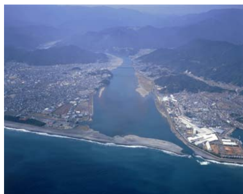
写真7 河口砂州と熊野川
