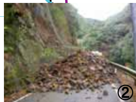
くまのがわちよう たまきぐち 熊野川町玉置口地区で 発生した土砂崩落 (平成20年1月)
