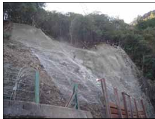
▲法面復旧の状況
