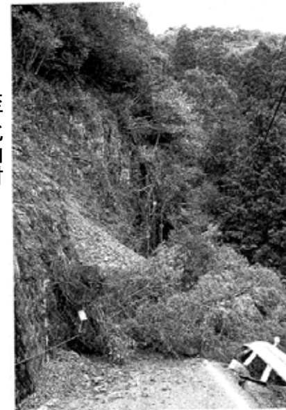
国道169号の土砂崩れ現場 ＝16日、新宮市熊野川町玉置口
