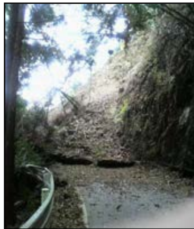
▲土砂崩落の状況
