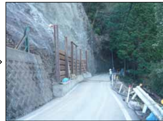
▲仮復旧の状況
