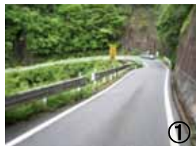
くまのがわちようくじゅう 熊野川町九重地区の 線形不良区間の状況
