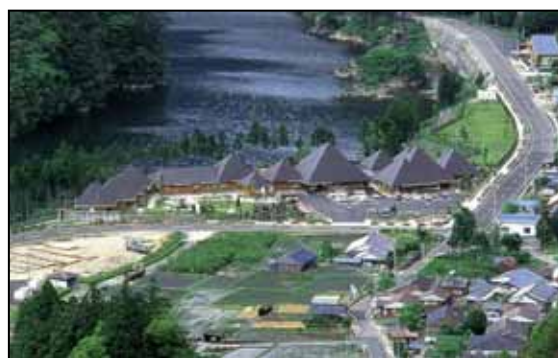
写真 道の駅「おくところ」・宿泊施設
