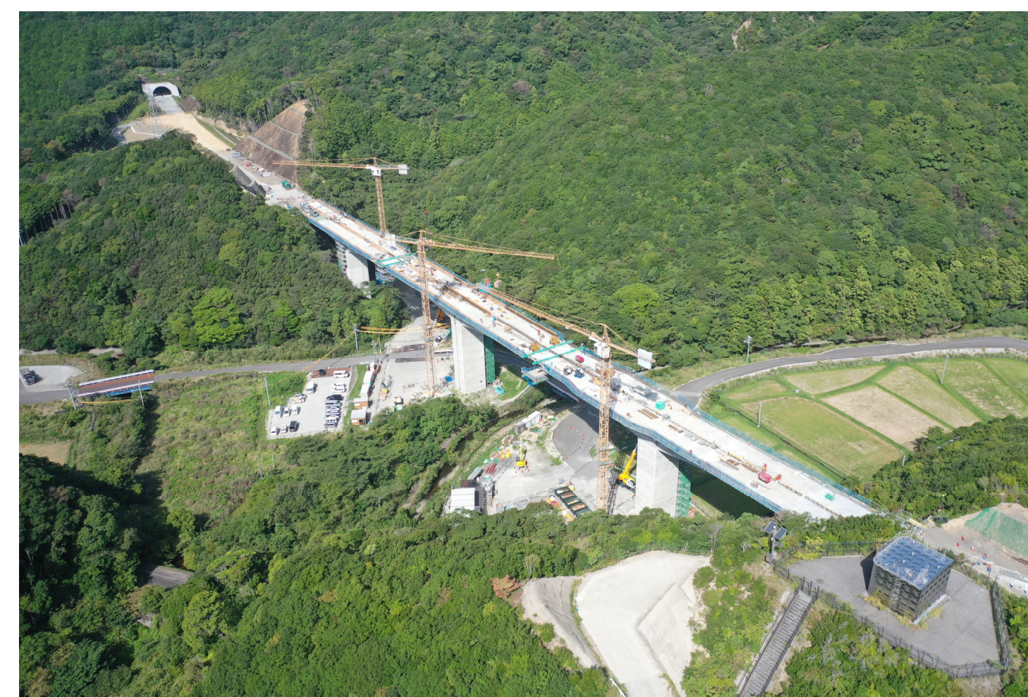
⑦串本町關野川(關野川橋)
