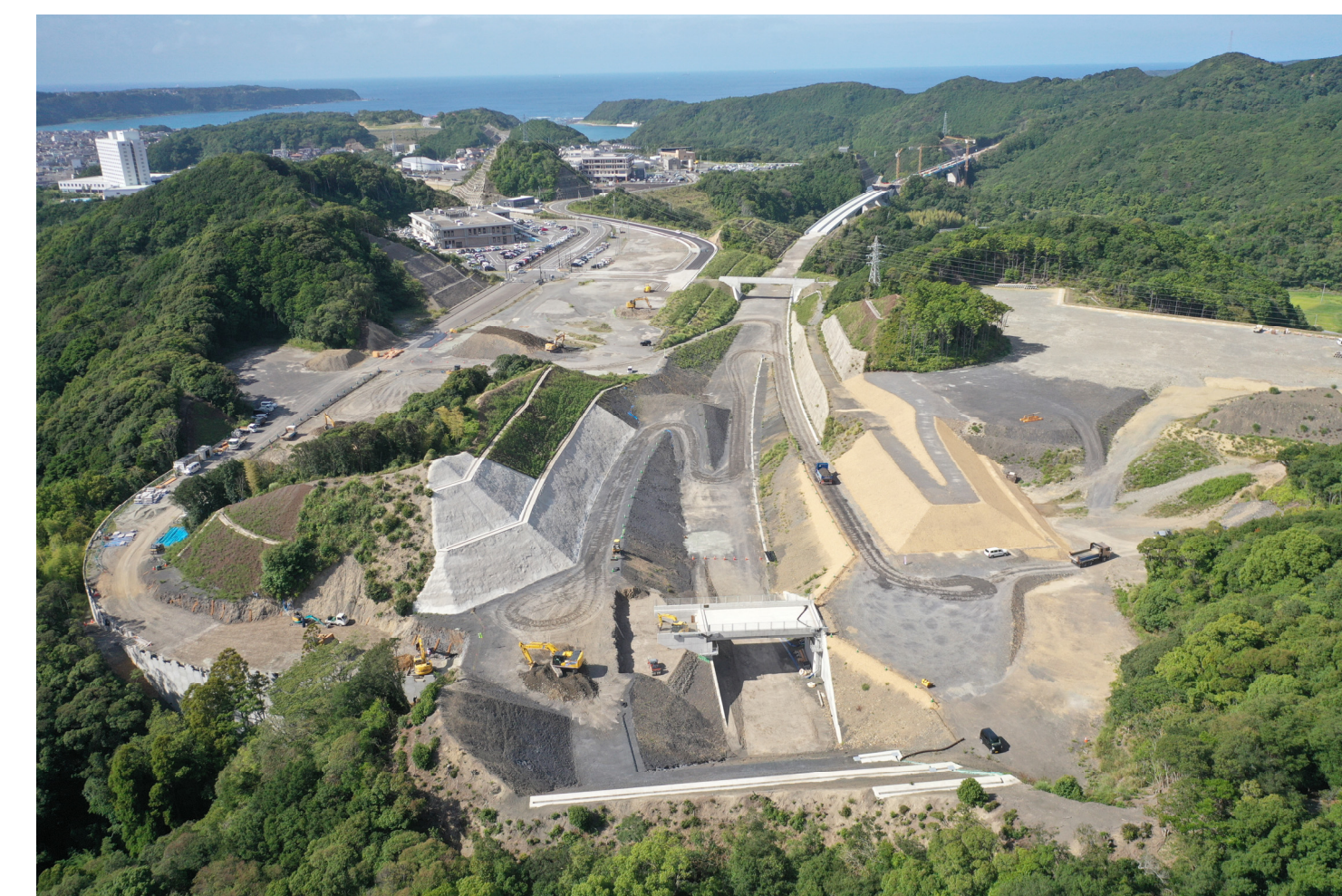
⑧串本IC仮称 (道路改良)
