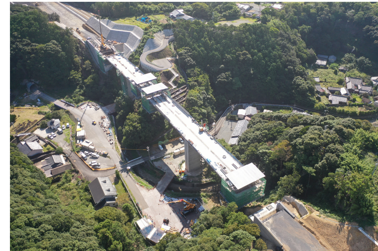
④串本町田子(田子川橋)
