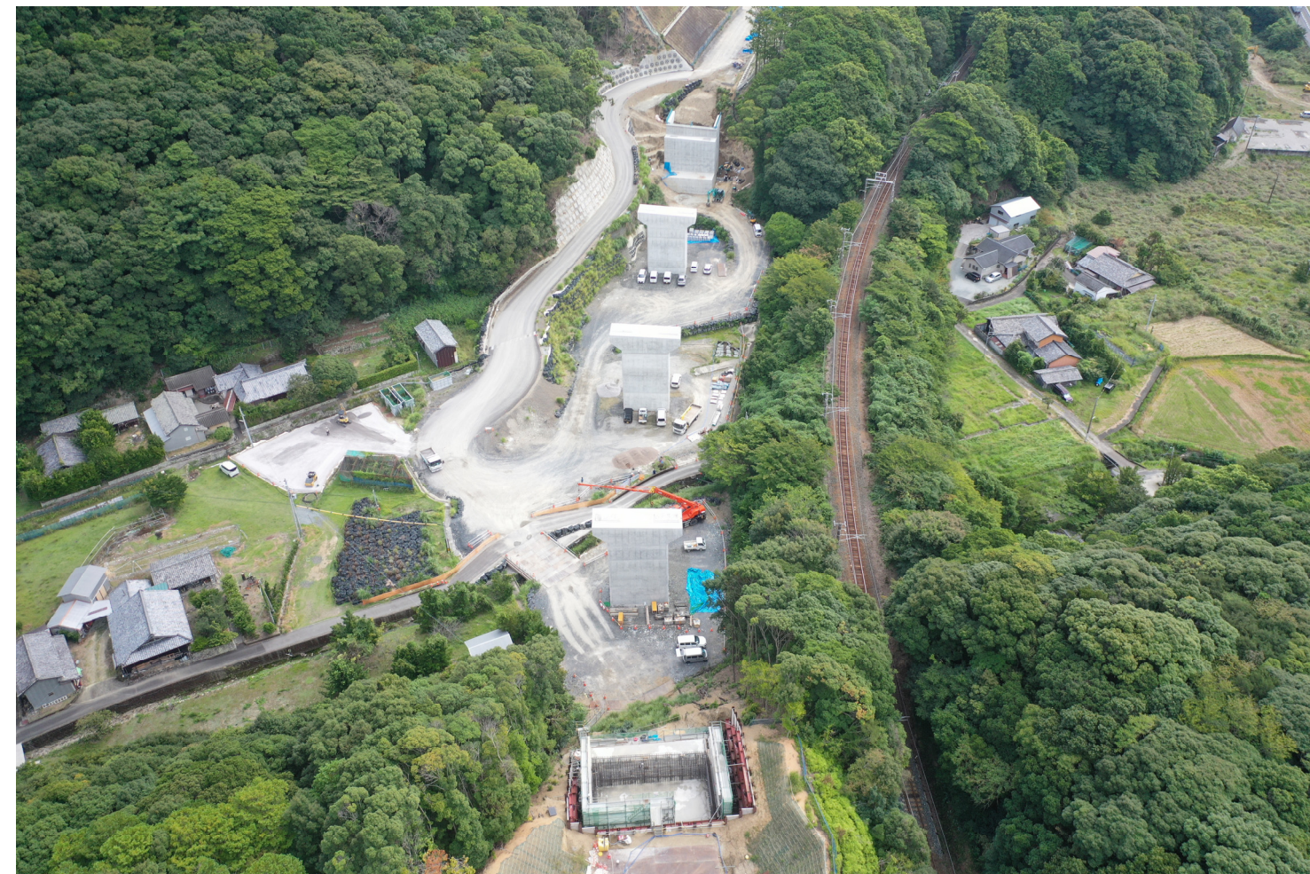
②すさみ町里野(小河瀬谷川橋)
