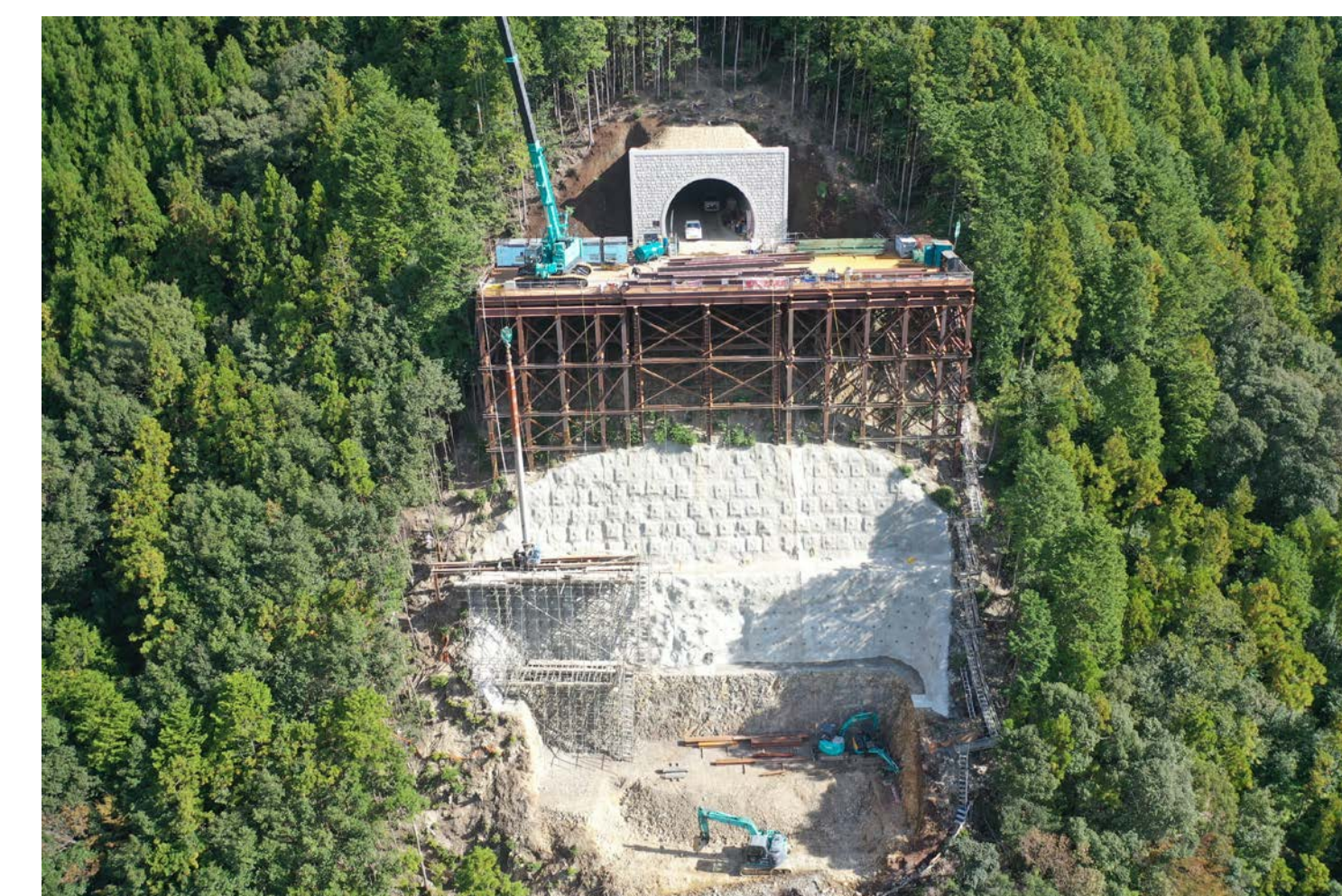
⑧ 北山村小松(2号トンネル・3号橋)
