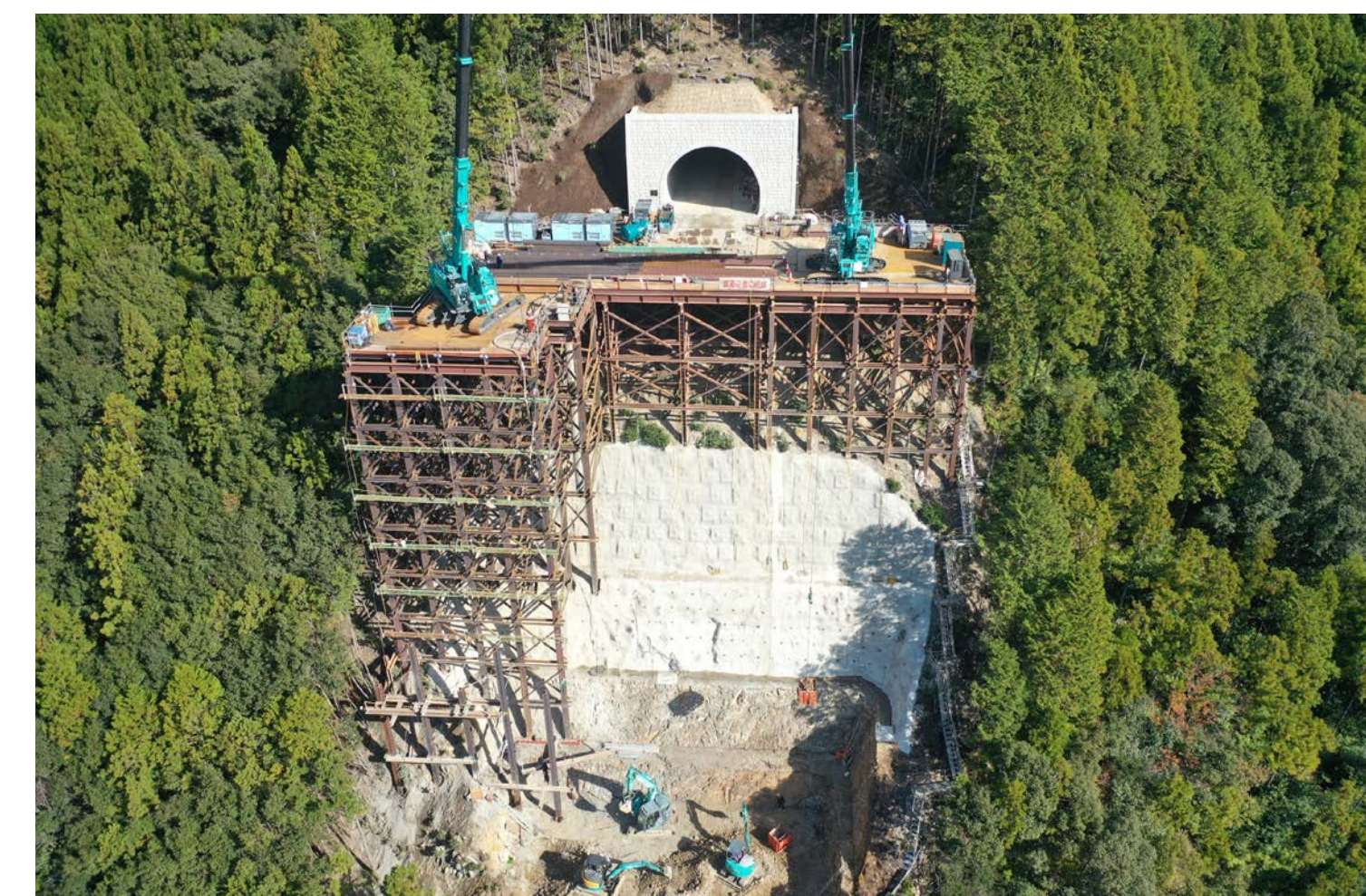
⑧ 北山村小松(2号トンネル・3号橋)
