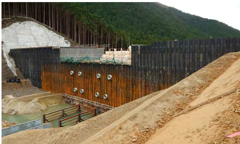
基幹となる砂防堰堤（熊野地区）
