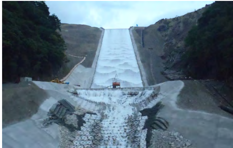
ブロックによる護床工が設置された仮排水路下流端（栗平地区） 平成 24 年 9 月
