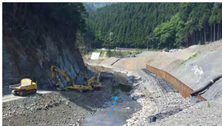
河道断面を確保するための対岸掘削状況（坪内地区）
