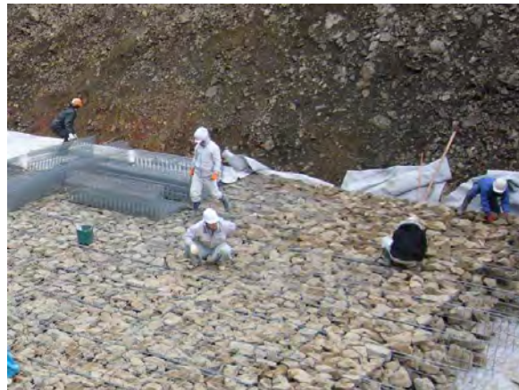
かごマット工への礫設置状況（長殿地区）
