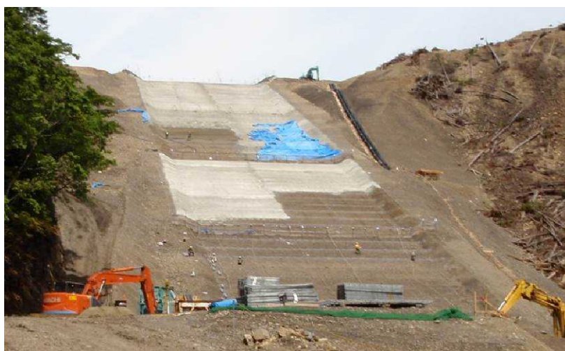
砂防ソイルセメント改良+モルタル吹付による水路工（栗平地区）
