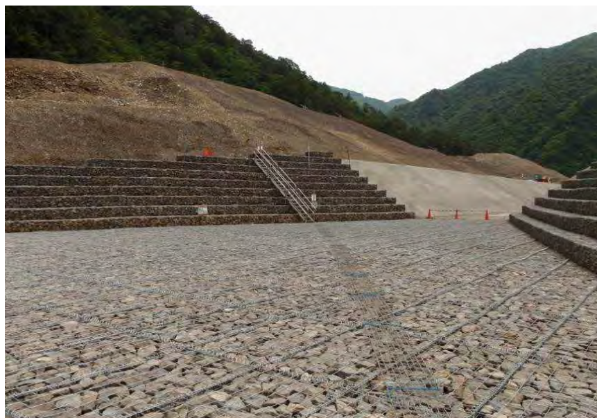
かごマット工による仮排水路（栗平地区／勾配変化点）
