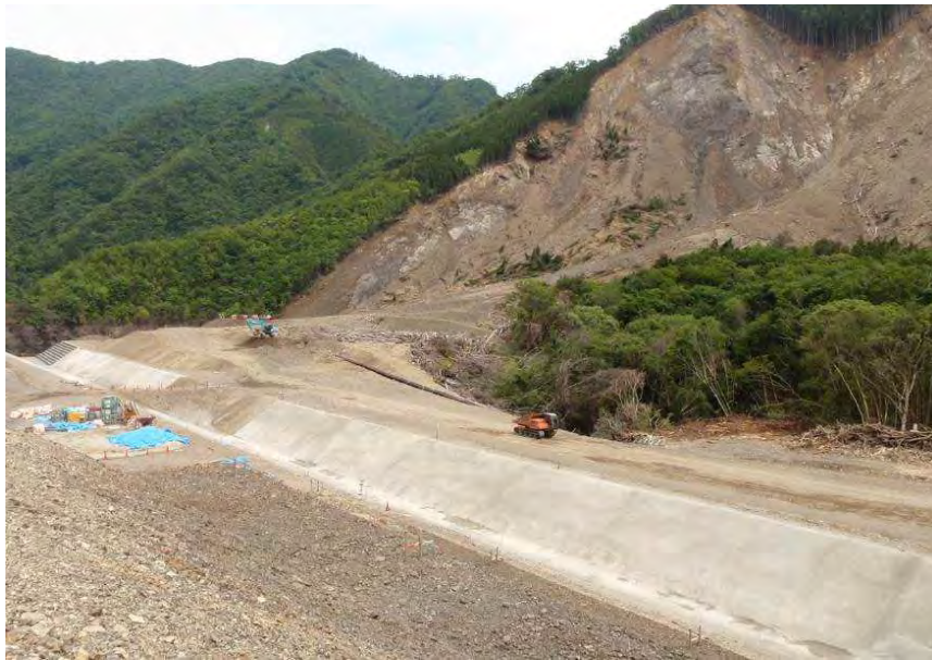
改良土+モルタル吹付による仮排水路（栗平地区／河道閉塞部天端）
