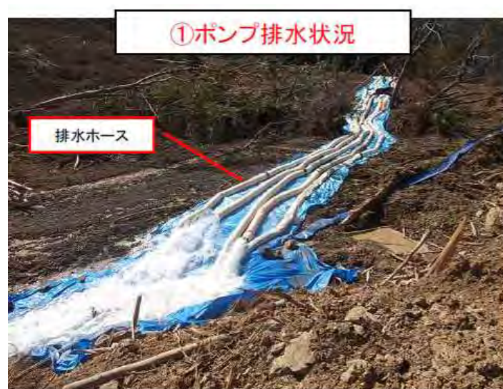
ポンプ排水の実施状況（赤谷地区）
