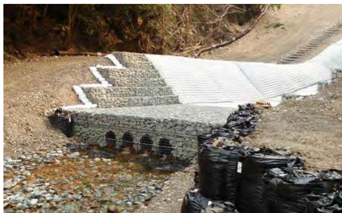
仮排水路下流端の湧水地点に設置した排水管（長殿地区）
