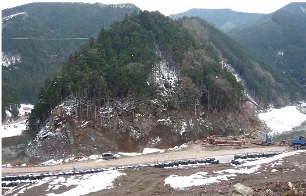
対岸掘削前の状況（坪内地区）
