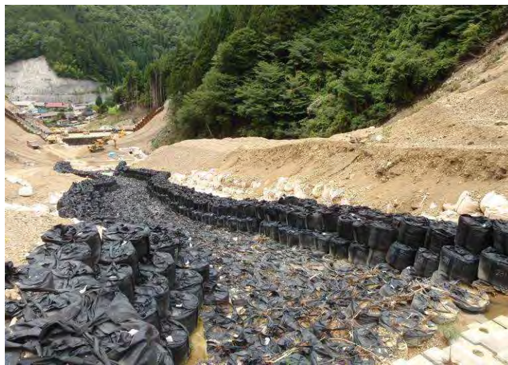
砂防ソイルセメントを中詰材とした大型土のう水路（北股地区）
