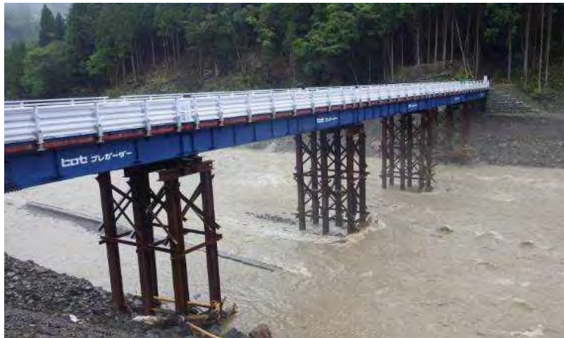
仮設橋による渡河（長殿地区）
