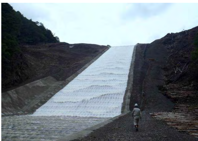
イボ型水路の流下状況（栗平地区）
