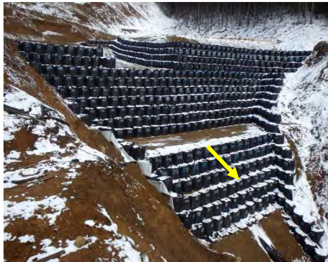
大型土のうを用いた谷止工による侵食防止対策（北股地区）
