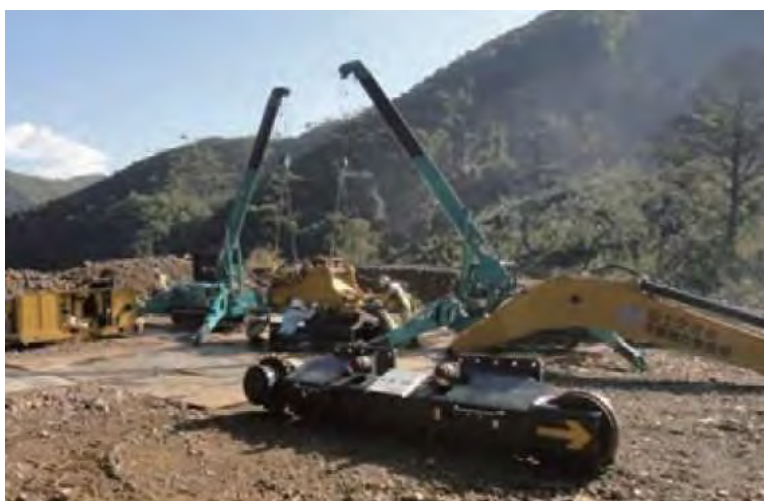
カニクレーンによる分解型重機の組み立て（長殿地区）
