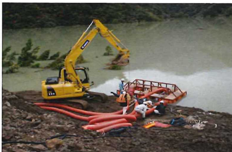
バックホウによる排水ポンプ設置状況（栗平地区）
