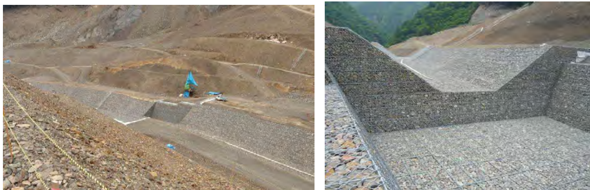
仮排水路施工状況（赤谷地区）
