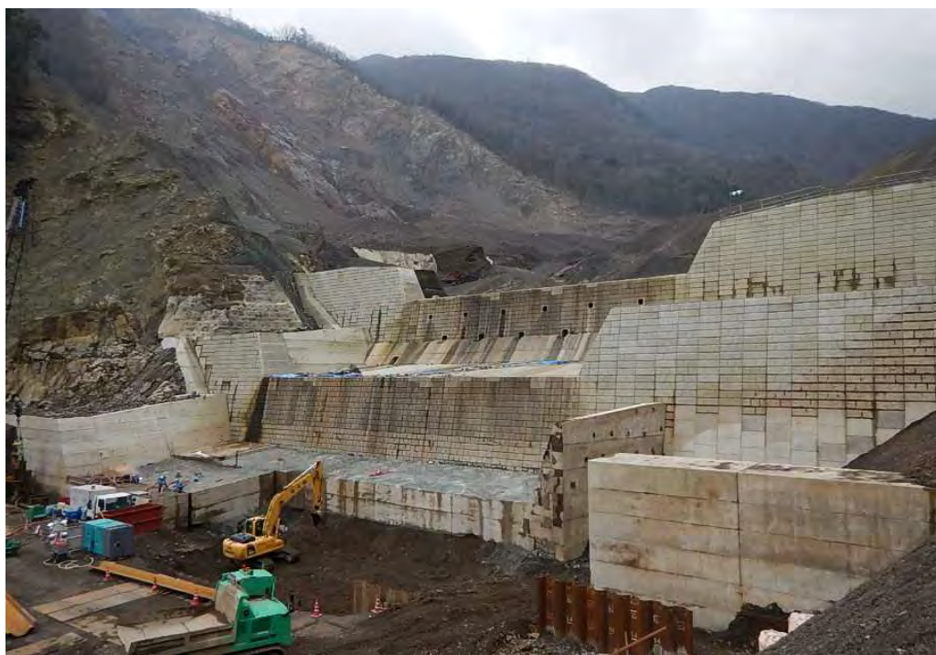
堰堤工群による河道閉塞対策（赤谷地区）
