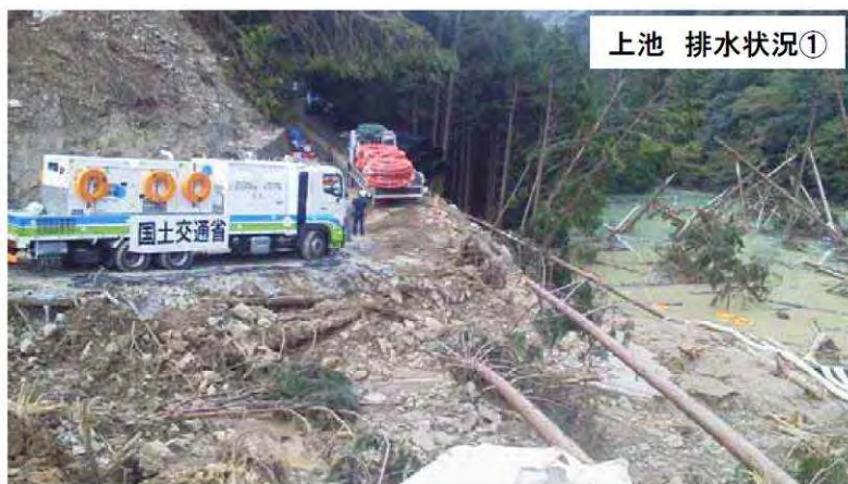
排水ポンプ車によるポンプ排水（熊野地区）
