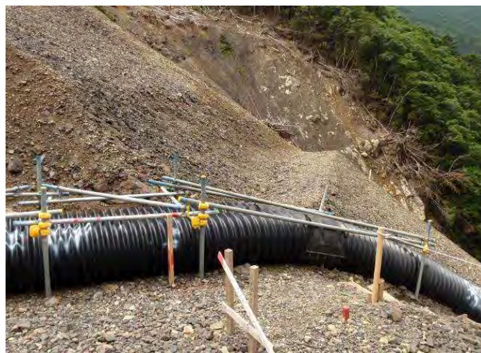
排水ホースの固定状況（栗平地区）
