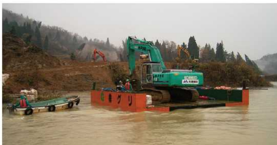
組み立て台船による大型重機の水上輸送 (東竹沢地区／平成 16 年新潟県中越地震)
