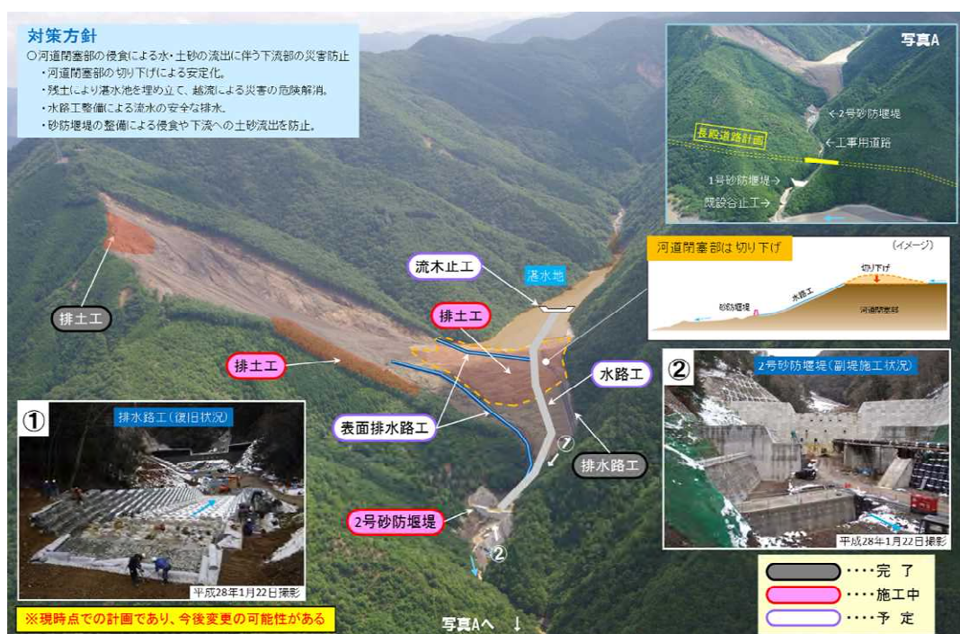
排水路工による河道閉塞対策（長殿地区）
