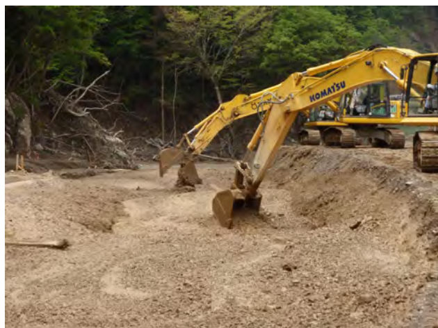
バックホウによる泥土の除去（赤谷地区）
