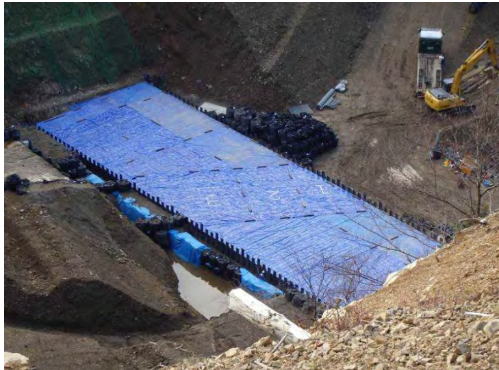
砂防ソイルセメント養生中の状況（北股地区）
