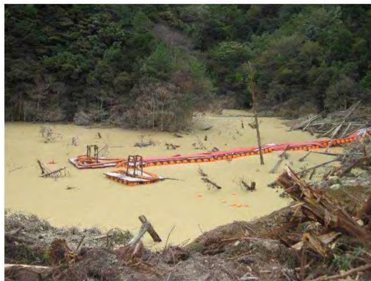
筏式フロート排水ポンプによるポンプ排水（熊野地区）
