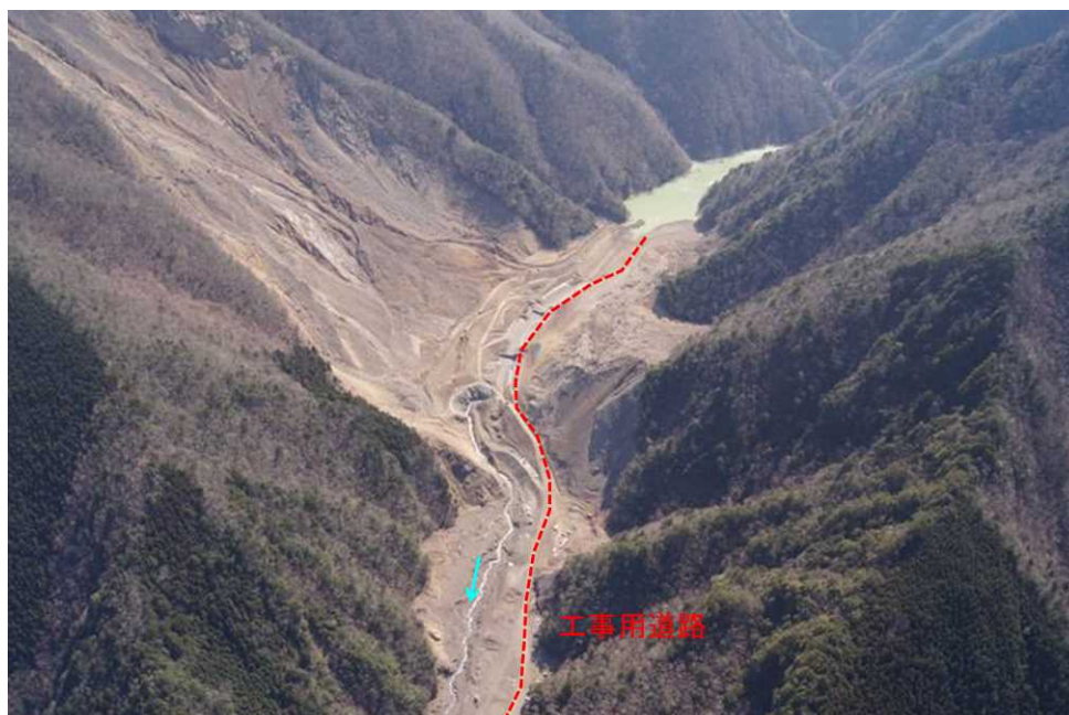
崩壊地对岸側への工事用道路設置（赤谷地区）
