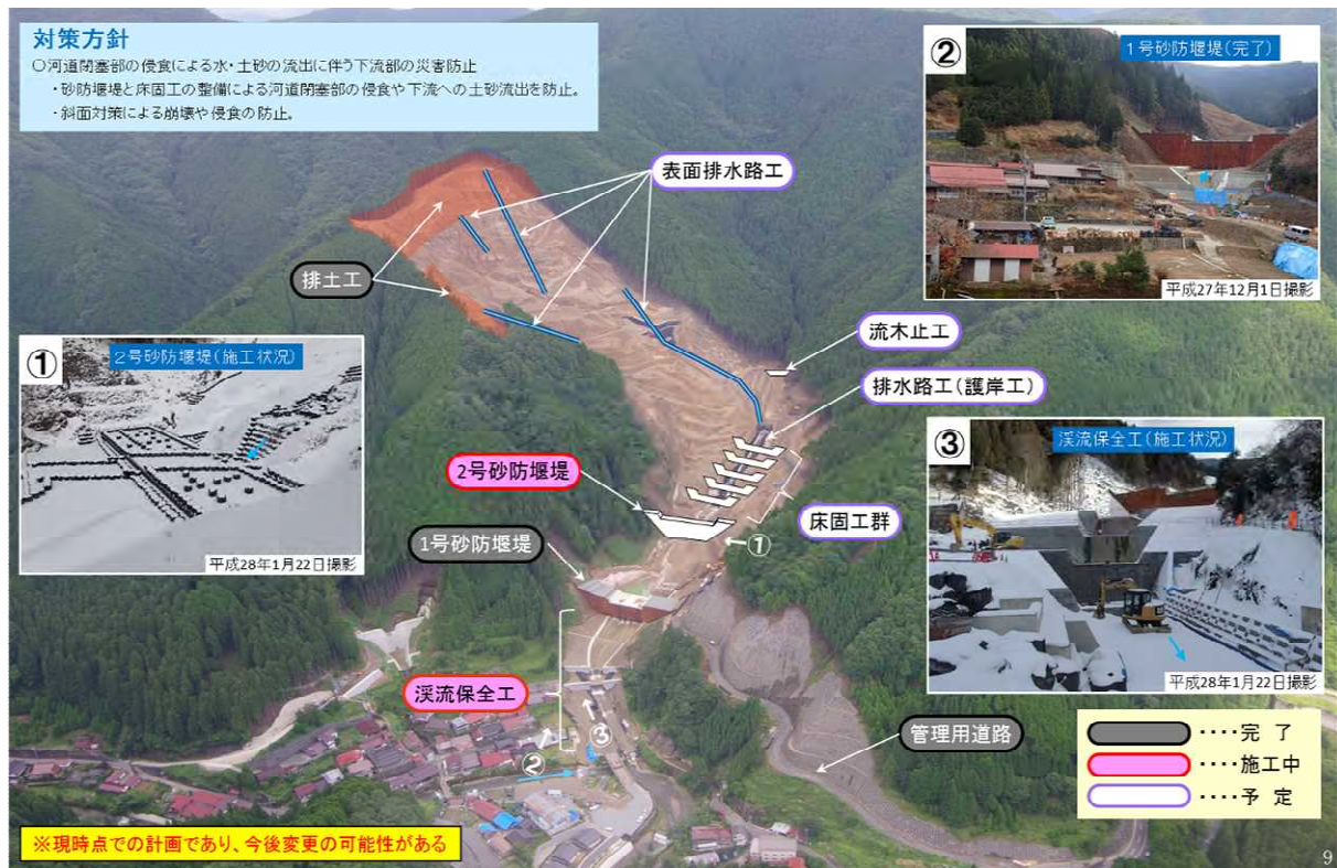
堰堤群による河道閉塞対策（北股地区）
