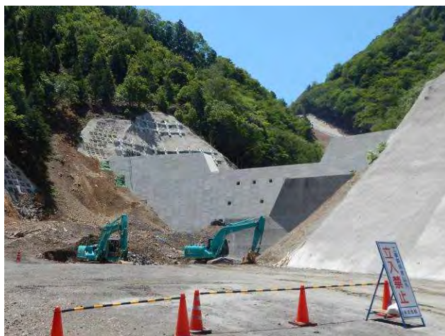
天然ダム脚部への基幹堰堤設置（長殿地区）
