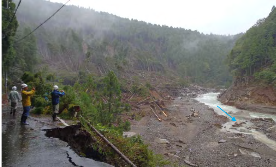
深層崩壊により寸断された県道の状況（坪内地区）
