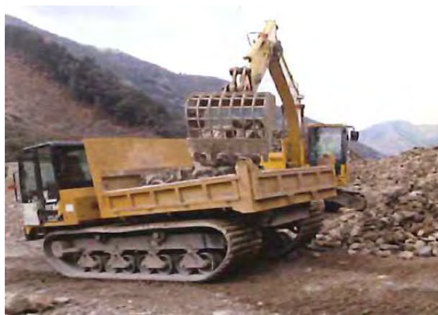
不整地運搬車（栗平地区）
