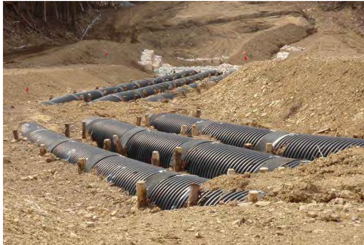
河道閉塞部下流法面への排水管の敷設状況（北股地区）
