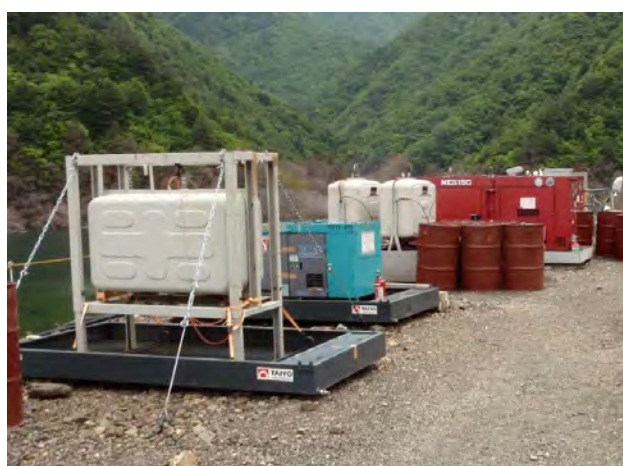
発電機・燃料タンク・オイルフェンスを設置した状態（左）と一体型発電機（右）
