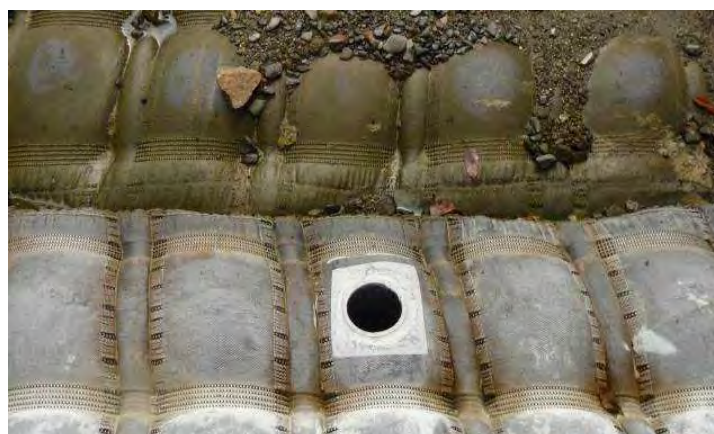
仮排水路底面に設けた穴（長殿地区）
