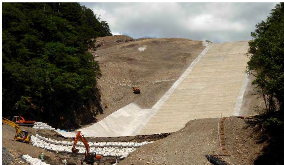
河道閉塞部下流法面に設置された工事用道路（栗平地区）
