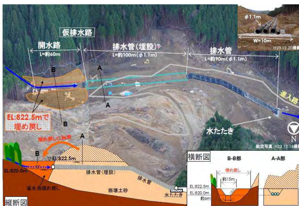
河道閉塞部の切り下げと湛水池の埋め戻し（北股地区）
