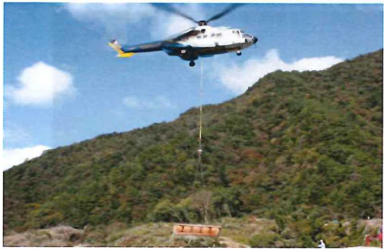
ヘリコプターによるポンプ資機材の輸送（栗平地区）
