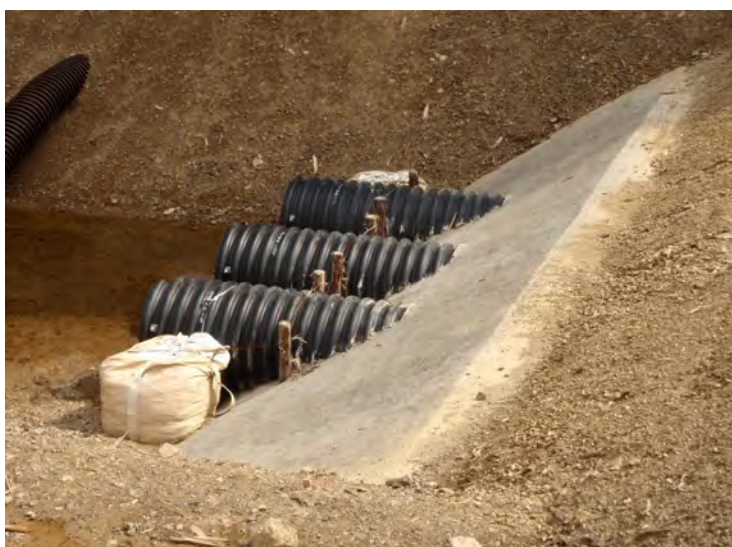
暗渠排水管呑口部の補強（北股地区）
