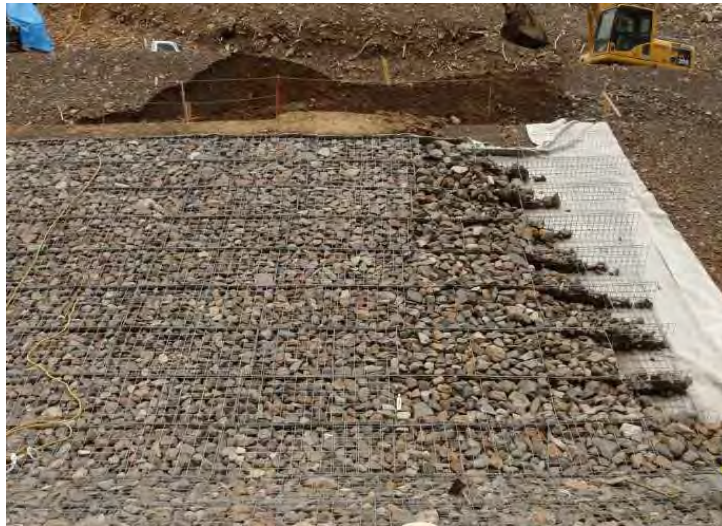
かごマット（平張り）施工状況（赤谷地区）
