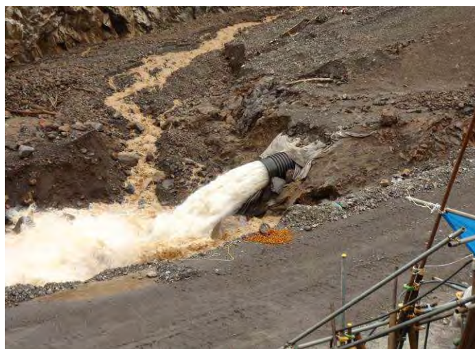
暗渠排水管吐口部の状況（赤谷地区）
