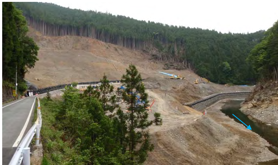
深層崩壊地の崩積土上に復旧された県道（坪内地区）
