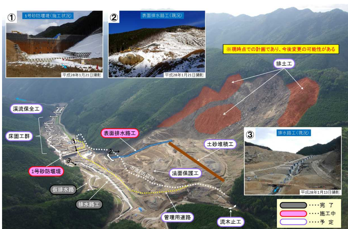
渓流保全工による河道閉塞対策（熊野地区）
