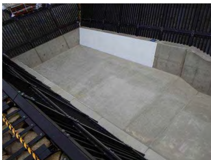
床固工直下の洗掘対策（熊野地区）
