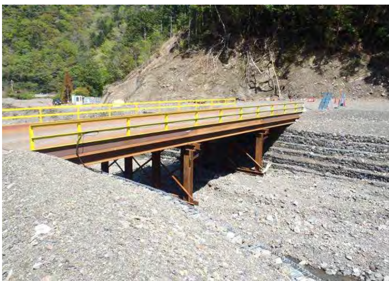
赤谷川渡河部の状況（赤谷地区） 上：コルゲート管、下：仮設橋
