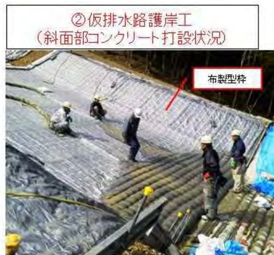
ポンプ打設による布製型枠水路工（長殿地区）
