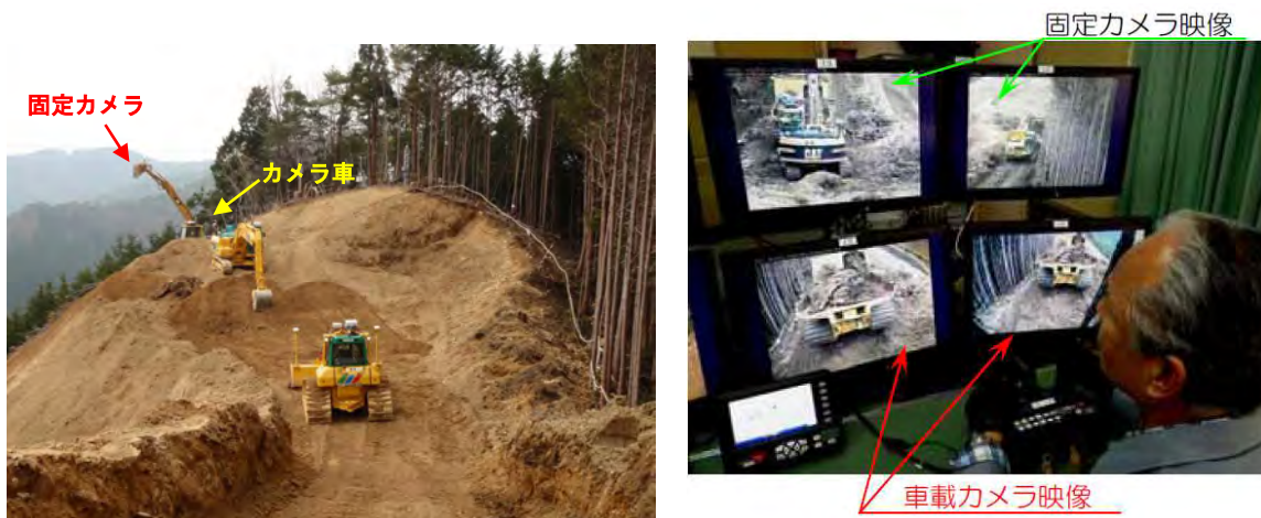
無人化施工による頭部排土（北股地区）
