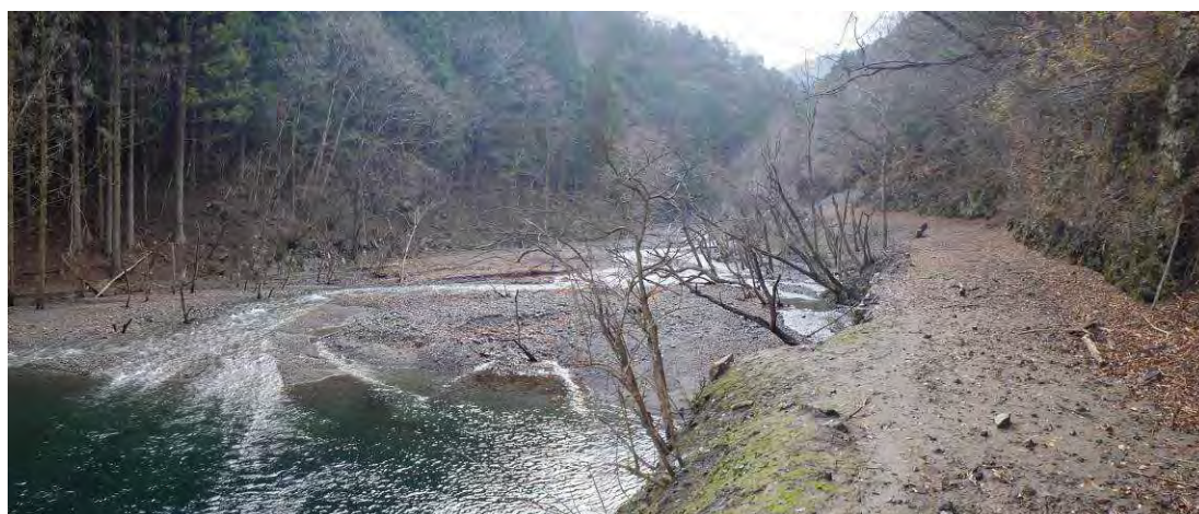
湛水池上流からの流入状況（赤谷地区）
