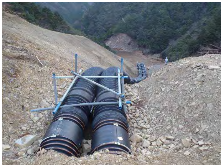
斜路への排水ホース設置状況（栗平地区）
