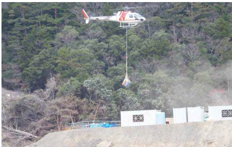
ヘリコプターによるドラム管の運搬（栗平地区）
