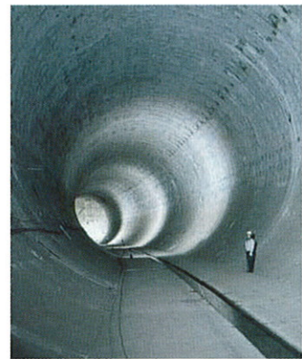
▲神田川・環状七号線地下調節地
