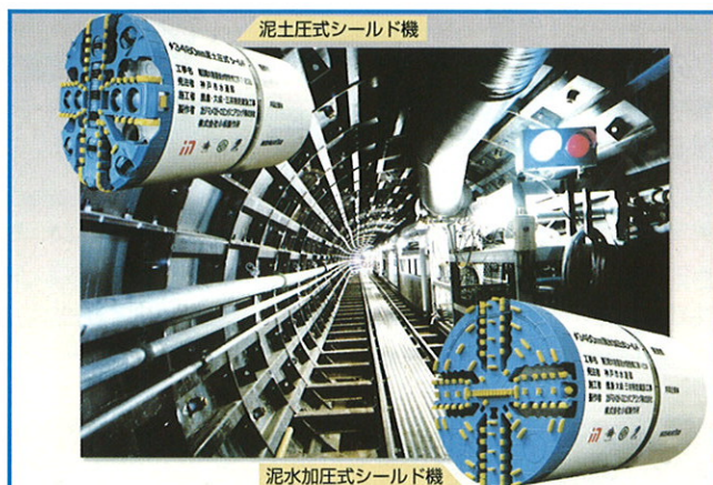
写真-3：シールドマシンとセグメントによる覆工状況
