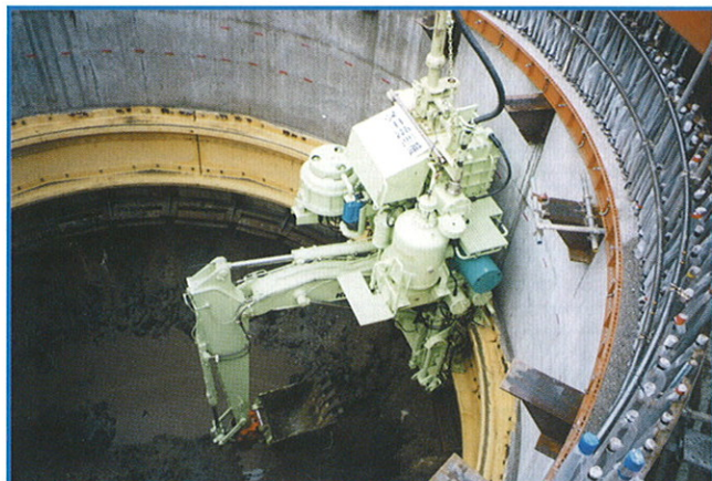
写真-1：本山立坑の掘削状況
