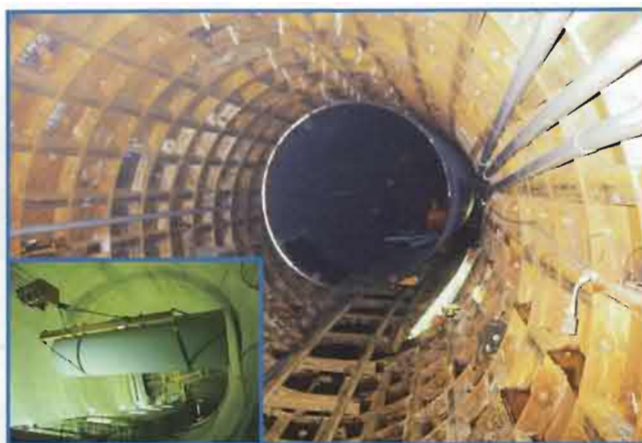
写真4：王子工区（鋼管吊り下ろし及び搬入状況）
