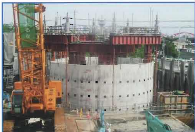
写真1：石屋川工区（立坑圧入沈設状況）
