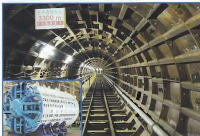
写真2：王子工区（シールドマシンとセグメントによる覆工状況）
