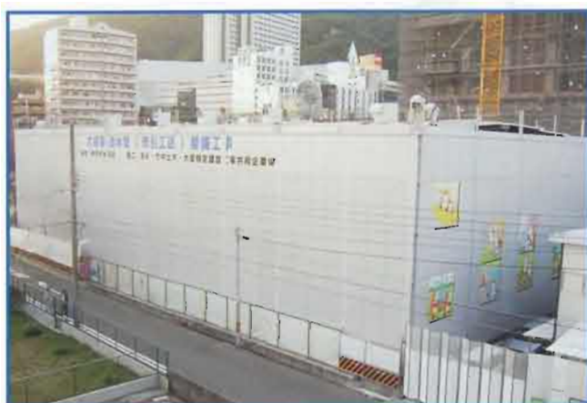
写真3：布引工区（シールド工用防音ハウス設置状況）
