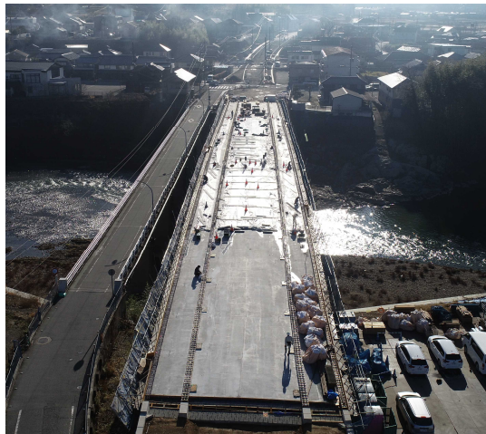
現場写真（橋梁架替工事）
