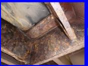
層状剥離や板厚減少を伴う腐食、排水桝固定用のナット脱落
