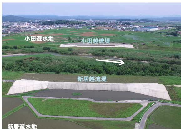
越流堤は本川堤の一部を低くし、洪水が一定の水位以上になった場合に、遊水地内に流入させる施設です。
