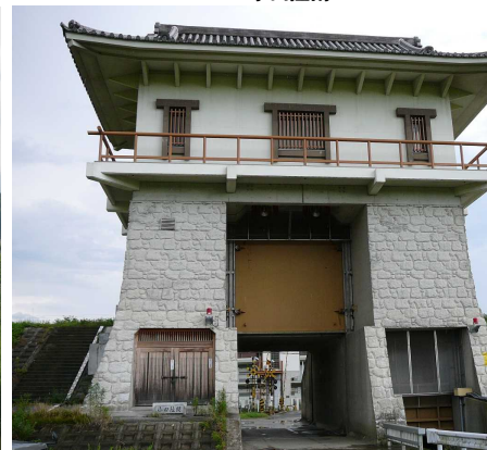
陸閘は堤防の役割を果たす開閉可能な門扉です。
