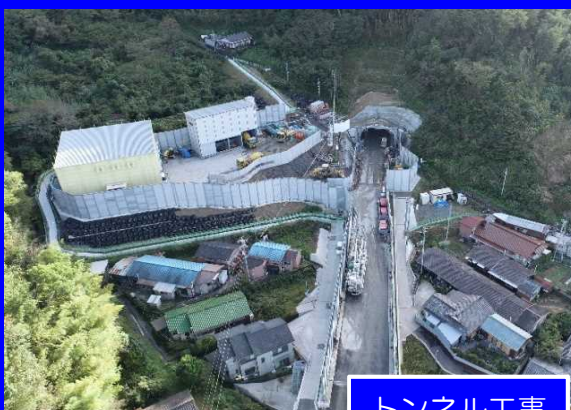
トンネル工事
