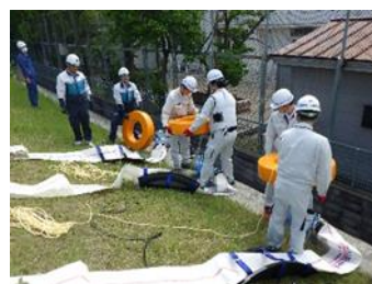
排水ポンプ車設営訓練（ポンプ投げ込み）
