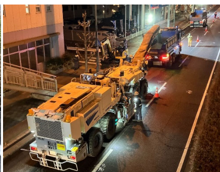
施工イメージ（路盤打換工）
