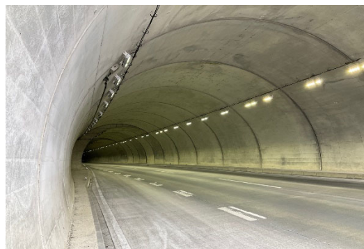
西脇北バイパストンネル照明 LED 化
