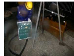
(薬液注入完了)
