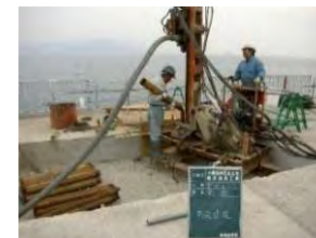
(薬液注入状況)
