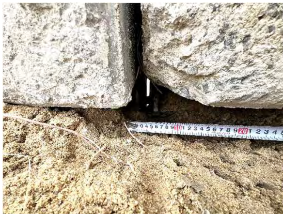
← ケーソン上部工
