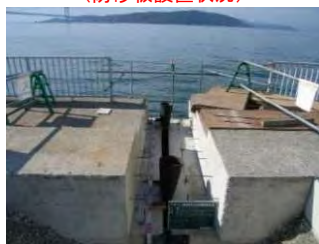
(目地設置状況)
