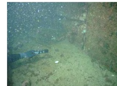
前面地盤の状況
