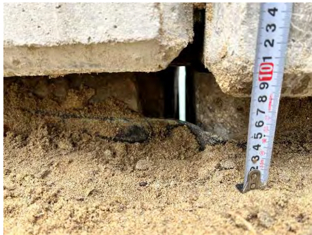
← ケーソン上部工
