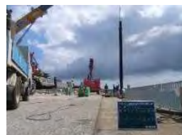
(目地施工状況)
