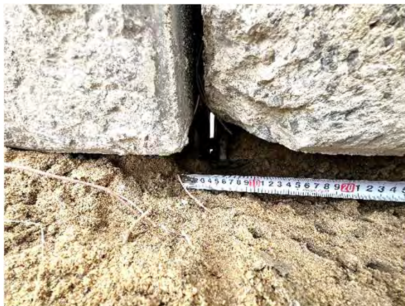
← ケーソン上部工
