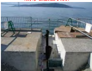
(目地設置状況)
