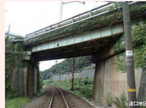
現況（側面全景）
