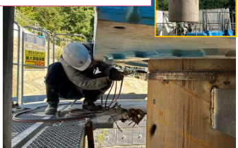
写真5 鋼管杭の切断状況
