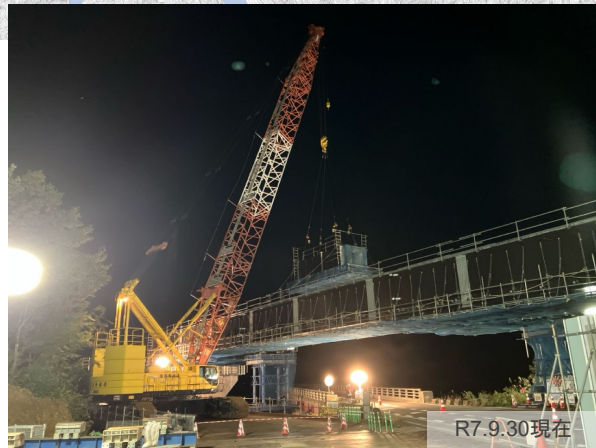
写真2 上部工架設状況
