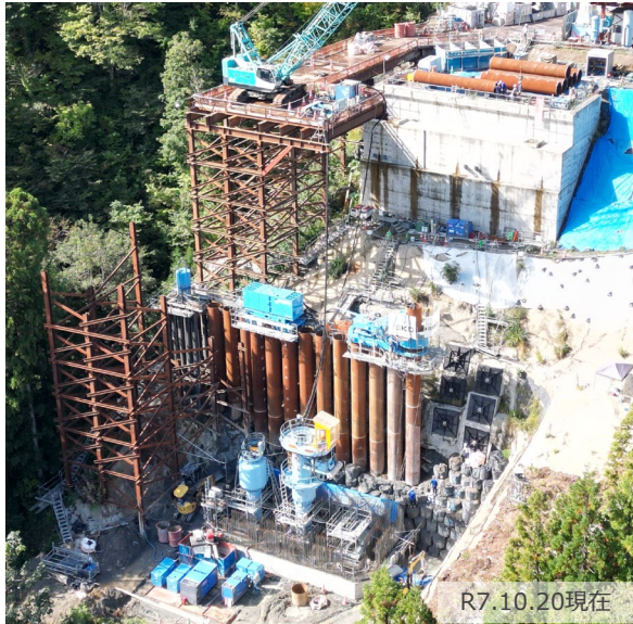
写真3 抑止杭の施工状況
