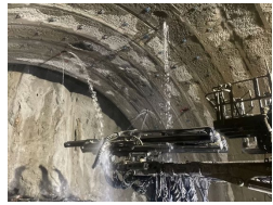
ロックボルト孔からの湧水状況
