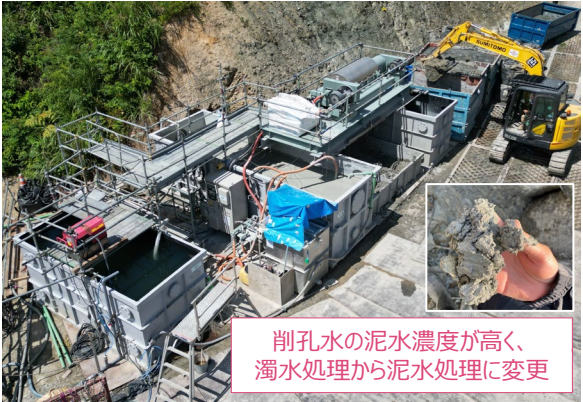
写真4 泥水処理の状況
