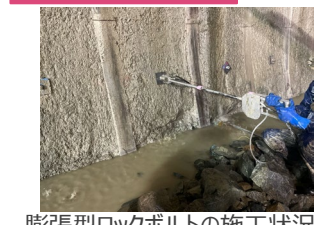
膨張型ロックボルトの施工状況
