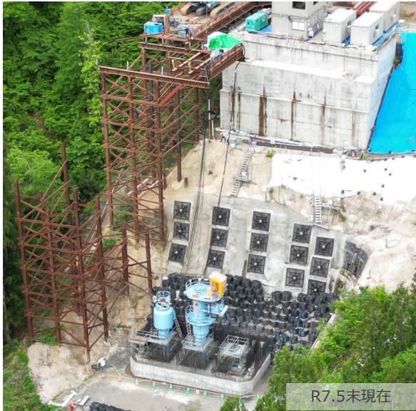
写真2 仮橋撤去・補強後の状況
