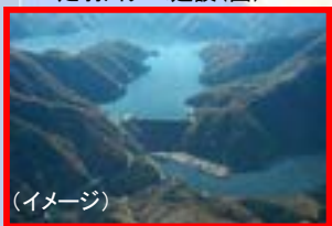
九頭竜川上流ダム再生（国）
