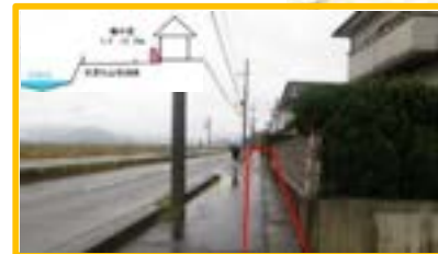
江古川地区の輪中堤整備(福井県)
