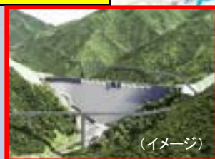
足羽川ダム建設（国）
