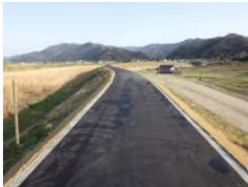
図 6.2.2 堤防天端の舗装
