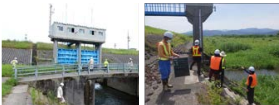
図 5.4.1 河川管理施設（樋門）の点検
