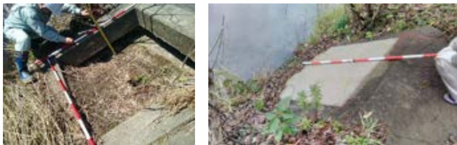
図 6.2.4 護岸の補修
