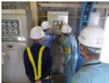
図 5.4.3 樋門機械設備等の点検
