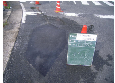
凹凸補修（パッチング）
