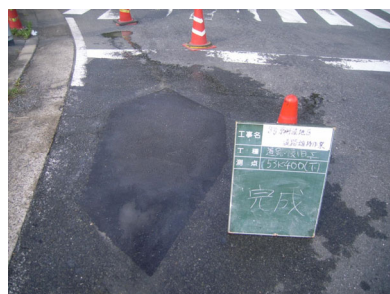
凹凸補修（パッチング）
