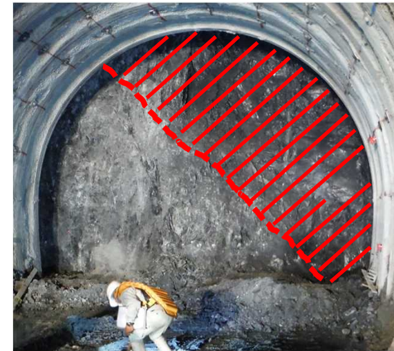
赤斜線部は脆弱層（破碎帯）を示す
