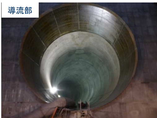
立坑内施工中
