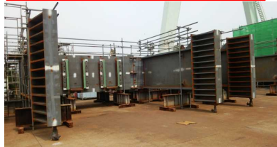
主ゲート基礎材(埋設部)
