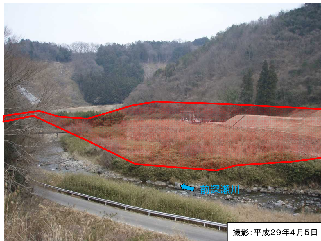
下流工区現況写真
