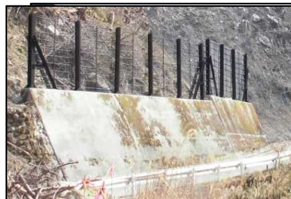
落石防護柵工
