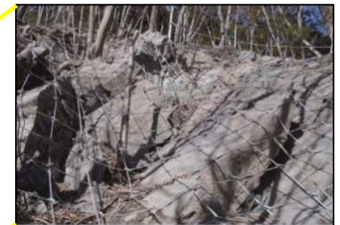
ロープ o 伏工
