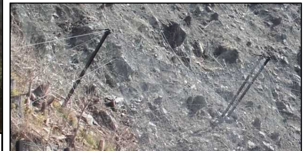
落石防護網工
