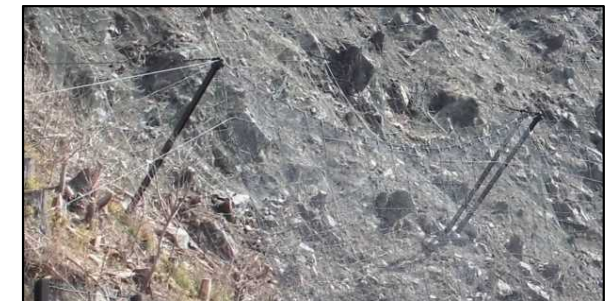
落石防護網工
