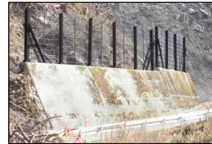
落石防護柵工
