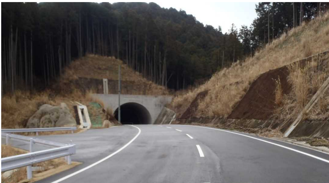
北野トンネル(現況)
