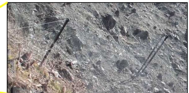
落石防護網工
