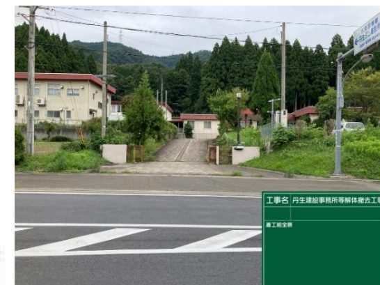
旧建設事務所撤去前
