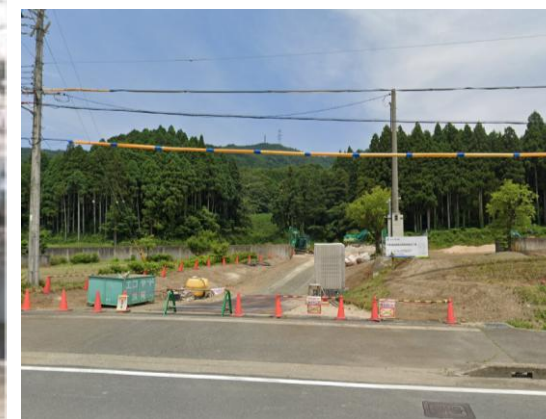
旧建設事務所撤去後
