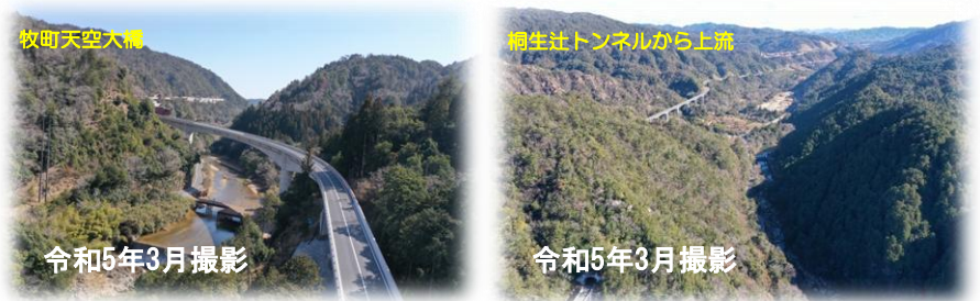
県道大津信楽線の付替完了 (令和5年3月)
