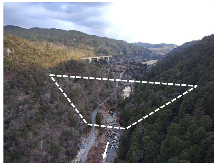
大戸川ダム建設予定箇所 現地状況(令和7年1月撮影)
