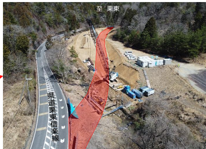
迂回路設置工事 現地状況(令和8年3月時点)
