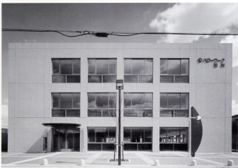
Yodogawa Public Employment Security Office 淀川公共職業安定所 (大阪市淀川区 完成平成14年3月)
