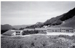
Sori National Children's Center 国立曽根少年自然の家 (奈良県宇陀郡 完成昭和55年12月)
