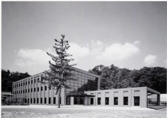
Welfare Center of Maritime Safety School 海上保安学校厚生棟 (京都府舞鶴市 完成平成7年11月)
