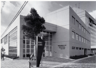
Kaneko National Government Building for Ministry of Justice 亀岡法務総合庁舎 (京都府亀岡市 完成平成25年11月)
