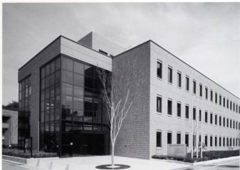
Aioi National Government Building 相生地方合同庁舎 (兵庫県相生市 完成平成7年9月)
