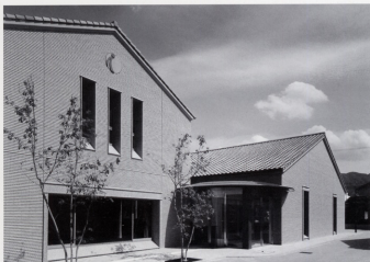
Kainan Public Employment Security Office 海南公共職業安定所 (和歌山県海南市 完成平成17年4月)
