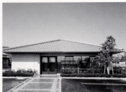
Ikaruga Branch of Nara District Legal Affairs Bureau 奈良地方裁判所伊弉岐出張所 (奈良県生駒郡 完成昭和63年2月)
