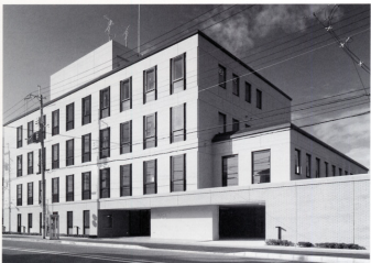
Fushimi Branch Office of Kyoto District Legal Affairs Bureau 京都地方法務局伏見出張所 (京都市伏見区 完成平成26年12月)
