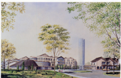
Osaka Institution of Special Nursing for Injured Workers 大阪労災特別介護施設 (大阪市東区 完成平成19年3月予定)
