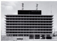
Osaka National Government Building NO.2 大阪第2地方合同庁舎 (大阪市中央区 完成昭和44年1月)
