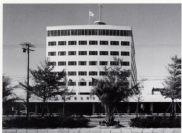
Osaka National Government Building for Port Office 大阪港湾合同庁舎 (大阪市港区 完成昭和48年10月)
