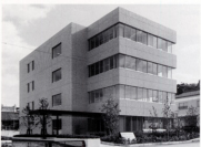
Fukuchiyama National Government Building 福知山地方合同庁舎 (京都府福知山市 完成昭和63年1月)
