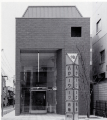
Kyoto Nishin Public Employment Security Office 京都西陣公共職業安定所 (京都市上京区 完成平成14年3月)
