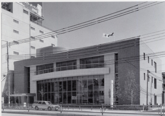
Osakanishi Public Employment Security Office 大阪西公共職業安定所 (大阪市港区 完成平成17年1月)
