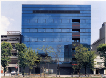
Tensoji Office of Osaka District Legal Affairs Bureau 大阪法務局天王寺庁舎 (大阪市天王寺区 完成平成17年1月)
