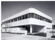
Fukui Local Finance Office 福井財務事務所 (福井県福井市 完成昭和54年10月)
