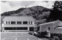
Tatsuno Branch of Kobe District Public Prosecutors Office 神戸地方検察庁龍野支部（兵庫県龍野市 完成平成2年4月）
