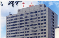
Osaka National Government Building No.3 大阪第3地方合同庁舎 (大阪市中央区 完成昭和49年1月)
