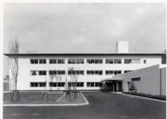
The Ground Improvement Office of Kinki District Agricultural Administration 近畿農政局土地改良事務所 (京都市伏見区 完成昭和48年10月)
