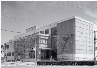
Nishiwaki National Government Building 西脇地方合同庁舎 (兵庫県西脇市 完成平成4年4月)
