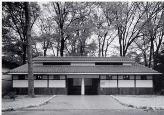
Public Lavatory in the Kyoto Imperial Garden 京都御苑公衆便所 (京都市上京区 完成平成5年4月)
