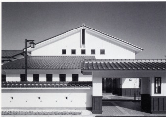
Orio National Government Building for Ministry of Justice 大野法務総合庁舎 (福井県大野市 完成平成4年12月)
