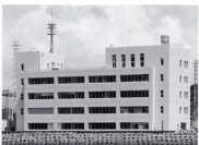
Tarabe National Government Building for Port Office 田辺港合同庁舎 (和歌山県田辺市 完成昭和60年4月)
