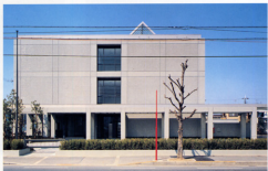
Yao Tax Office 八尾税務署 (大阪府八尾市 完成昭和61年1月)
