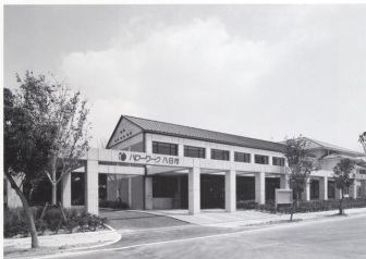
Yokaichi Public Employment Security Office 八日市公共職業安定所（滋賀県八日市市 完成平成4年7月）
