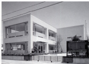
Kishiwada Public Employment Security Office 岸和田公共職業安定所 (大阪府岸和田市 完成昭和43年5月)
