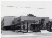
Nara National Government Building NO.2 奈良第2地方合同庁舎 (奈良府奈良市 完成昭和52年7月)
