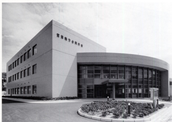
Miyazu National Government Building 宮津地方合同庁舎（京都府宮津市 完成平成3年3月）
