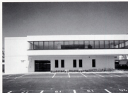
Ikeeda National Government Building for Ministry of Justice 池田法務総合庁舎 (大阪府池田市 完成昭和48年3月)
