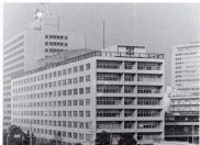
Osaka National Government Building NO.1 大阪第1地方合同庁舎 (大阪市中央区 完成昭和54年3月)
