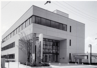
Hashimoto National Government Building 橋本地方合同庁舎 (和歌山県橋本市 完成平成18年4月)
