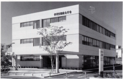
Ibari National Government Building for Ministry of Labor 伊丹労働総合庁舎 (大阪府伊丹市 完成平成13年1月)
