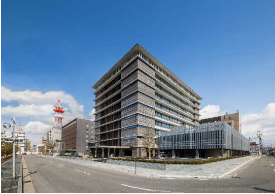
外観北西面（緑化）
