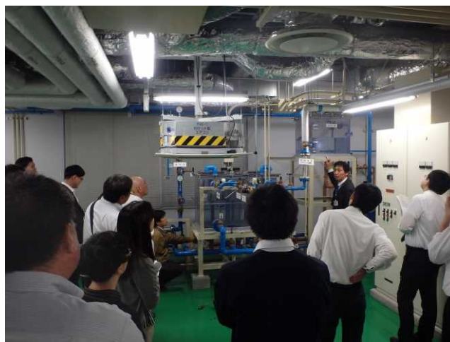
透明なパネル水槽で給水動作説明
