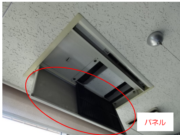
■FCU（天井カセット形）のパネルを取り外したところ
