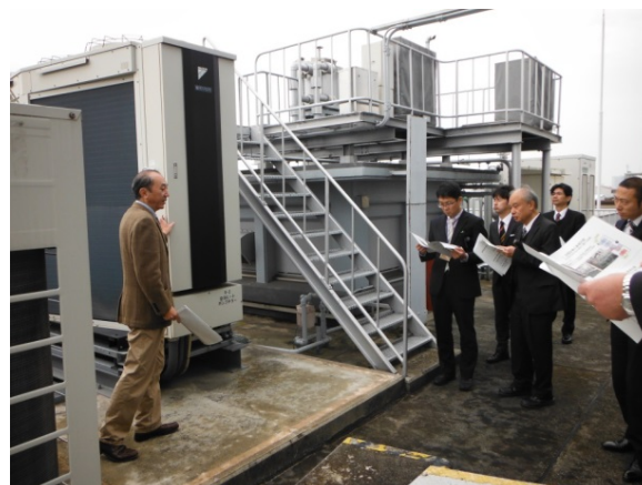
空気調和設備の実習風景 (冷房で使用する冷凍機の機能の説明)
