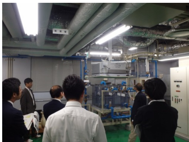
実習室で受水槽、高架水槽の給水動作を説明する様子
