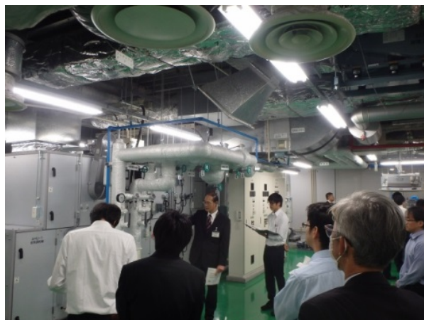
実習室で空気調和機の構造を説明する様子
