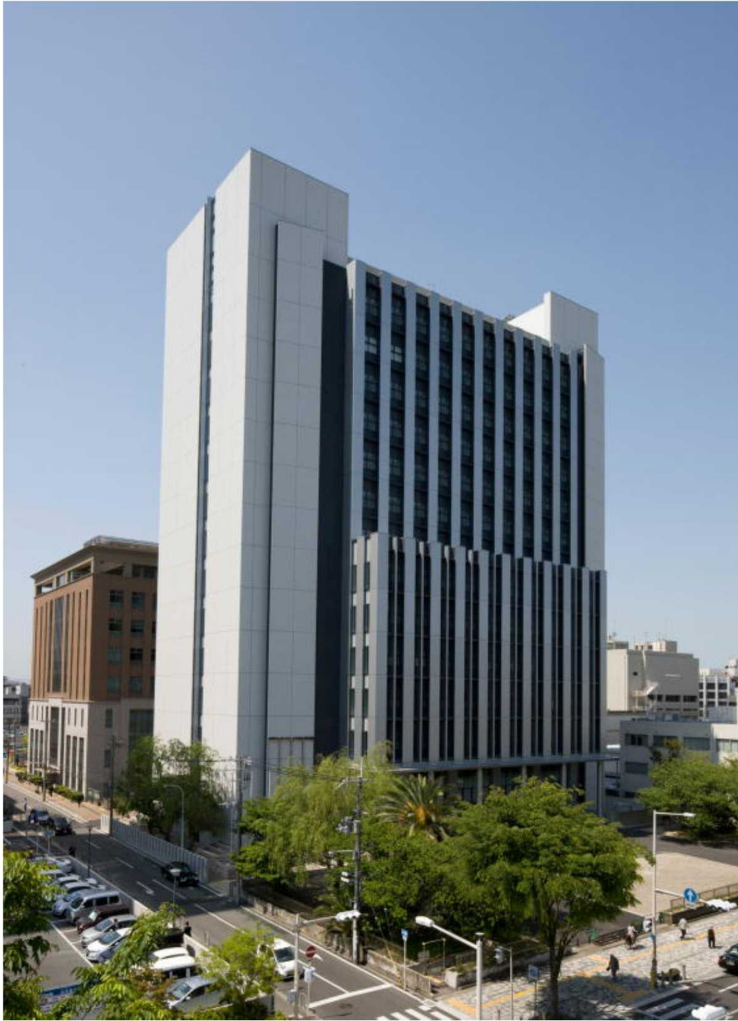
堺地方合同庁舎
