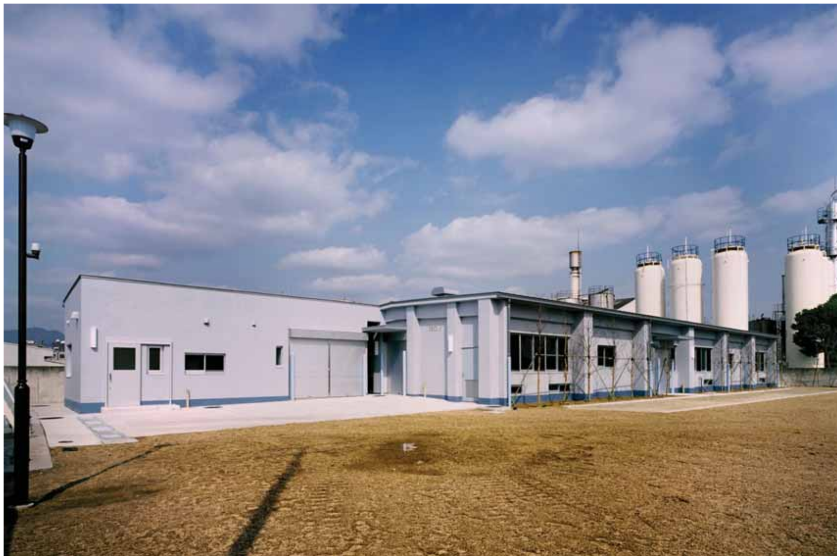
動物検疫所神戸支所苅藻動物検疫場畜舎
