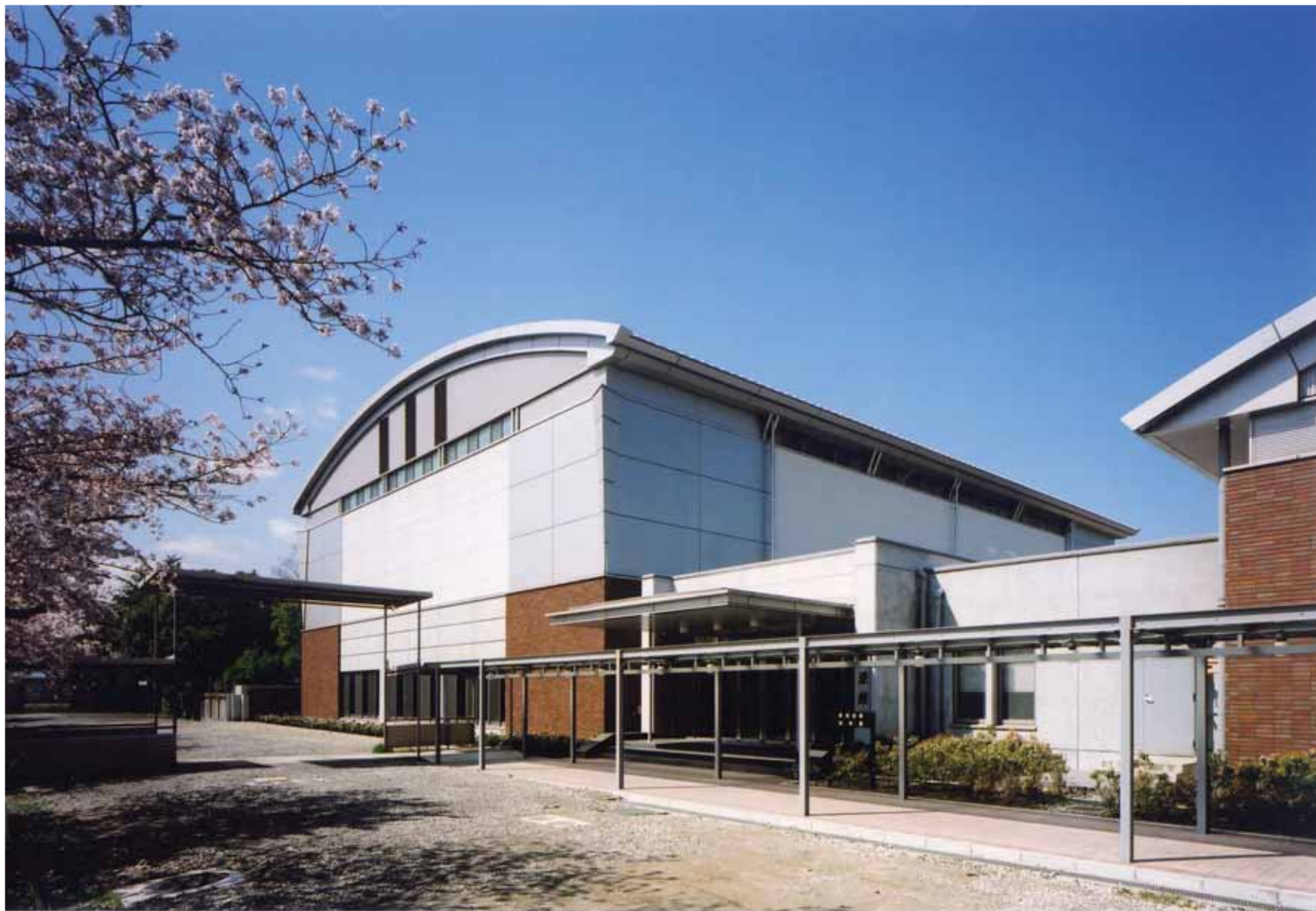
近畿管区警察学校体育館
