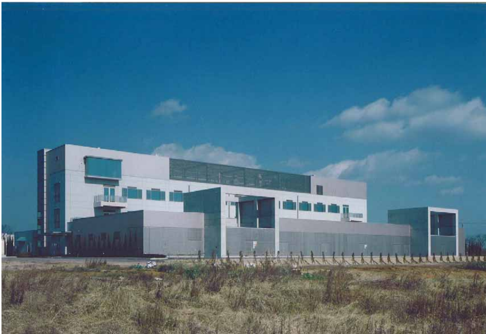
通信総合研究所第2研究棟
