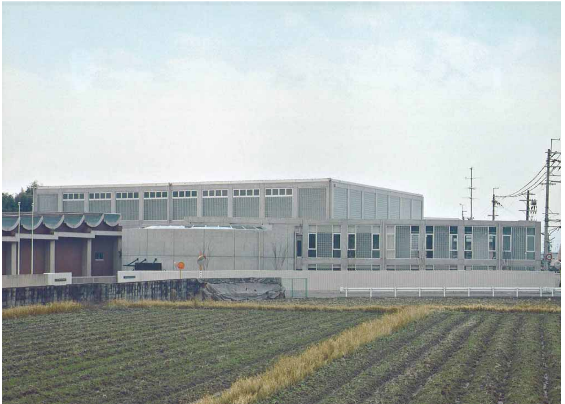
奈良県警察学校体育館
