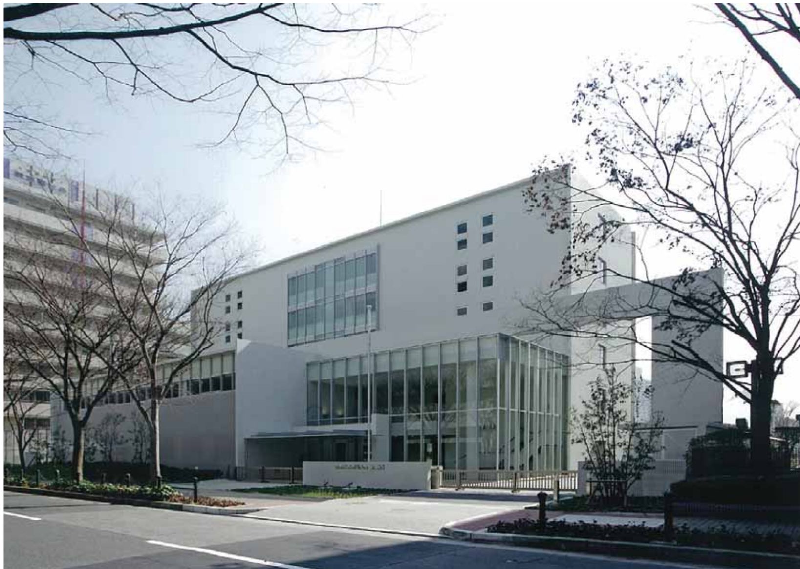
法務総合研修所大阪支所
