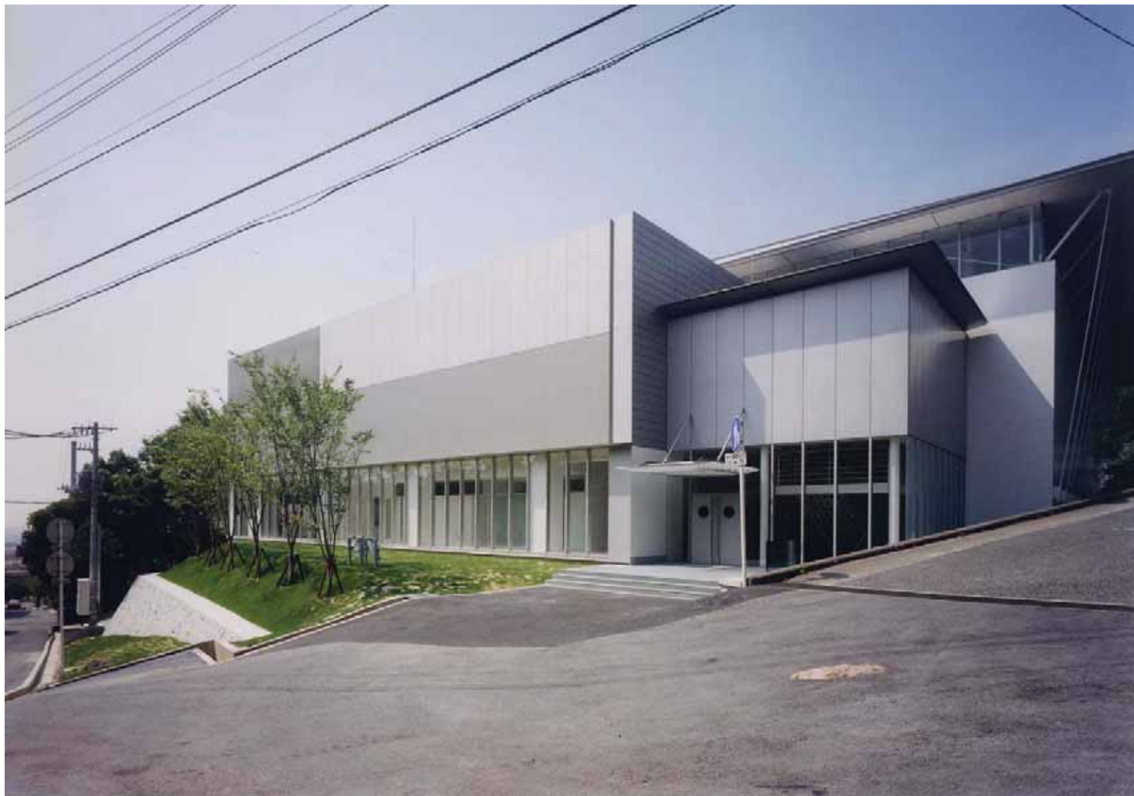
兵庫県警察学校体育館
