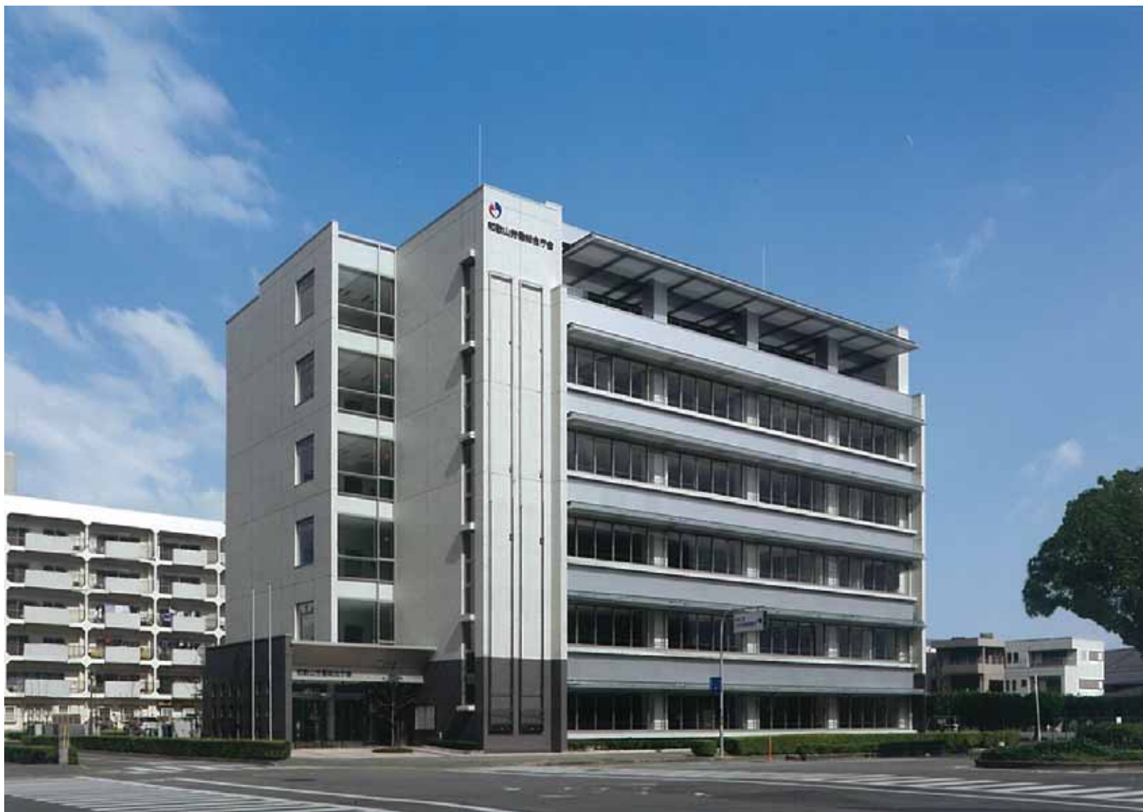
和歌山労働総合庁舎
