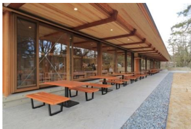
▼ 中立売休憩所のテラス
