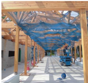
▼ 工事中の様子
