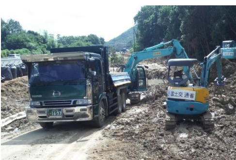
土砂の除去と道路啓開作業
