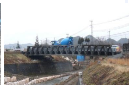
応急組立橋による交通路の確保
