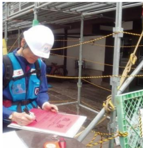
建物の危険度判定等点検支援
