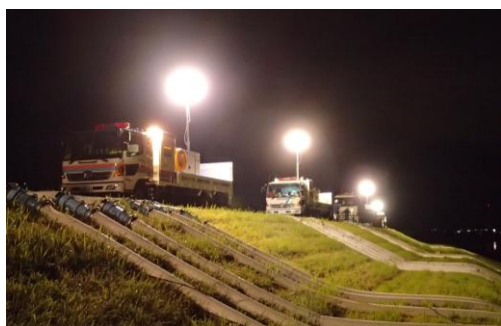
排水ポンプ車による緊急排水作業
