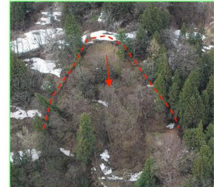
8/7 かなざわしひがしやま がけ崩れ 石川県金沢市東山
