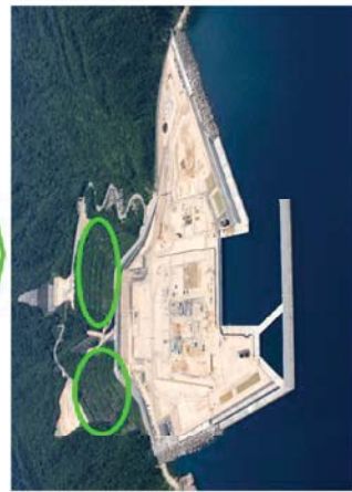
敦賀発電所3・4号機 予定地全景
