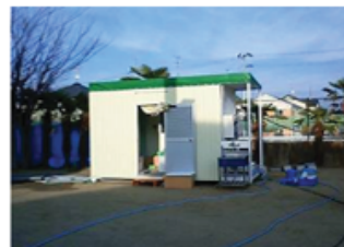
避難所設置のシャワーユニット
