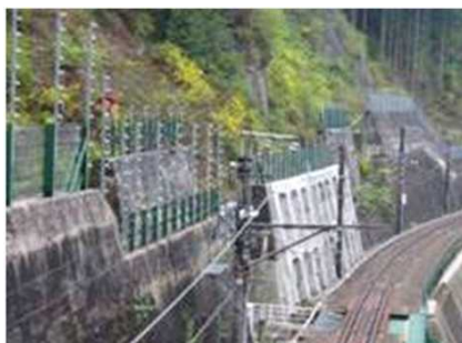
落石止擁壁と落石警報装置
